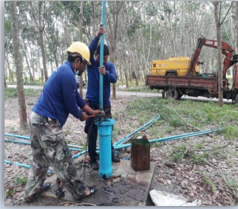
รูปภาพขณะรื้อถอนเครื่องสูบน้ำเพื่อเป่าล้างบ่อ
