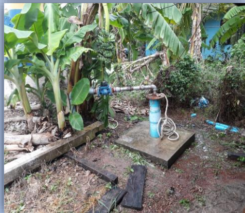
รูปภาพการติดตั้งเครื่องสูบน้ำและแสดงการสูบน้ำหลังเป่าล้าง
