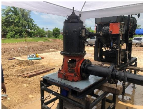
(จ) การติดตั้งเครื่องสูบน้ำบาดาลชนิดเทอร์ไบน์
