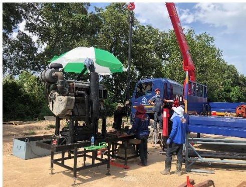
(ค) การติดตั้งเครื่องสูบน้ำบาดาล
