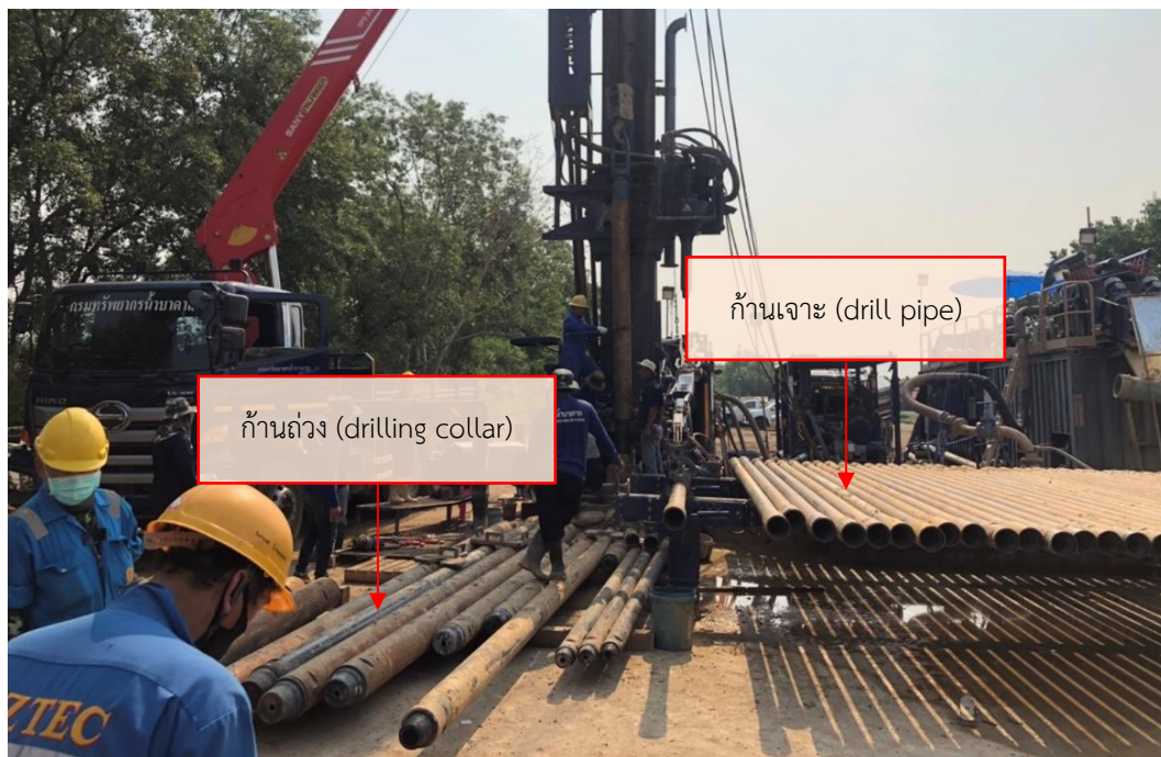
รูปที่ 4-39 ก้านเจาะ (Drill pipe) และก้านถ่วง (Drilling collar)
