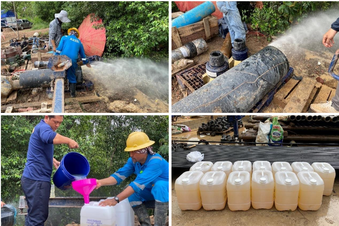
รูปที่ 4-69 ขั้นตอนการเก็บตัวอย่างน้ำบาดาล
