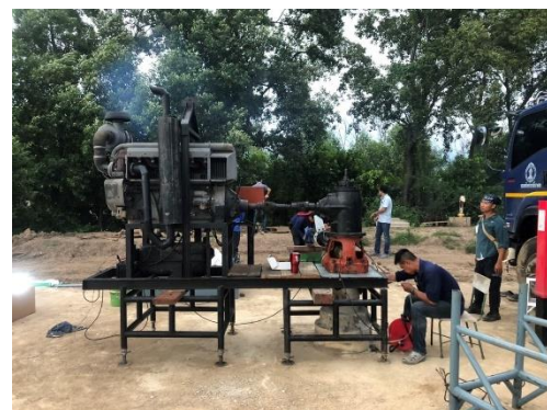
(ซ) ตรวจวัดระดับน้ำของบ่อสูบน้ำ และบ่อสังเกตการณ์
