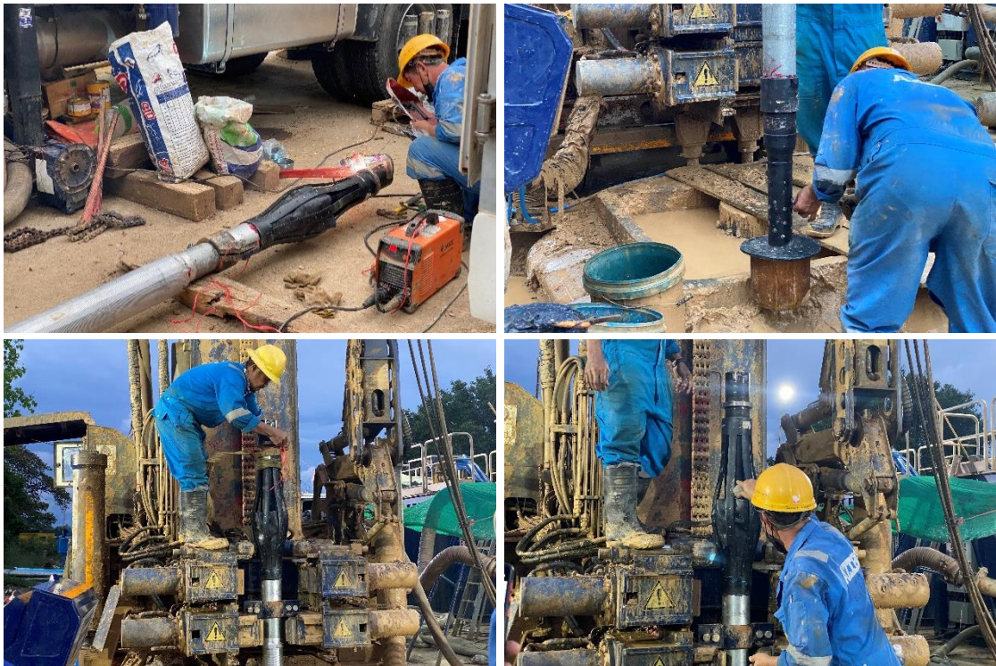
รูปที่ 4-67 ขั้นตอนการต่อกอุปกรณ์ packer test
