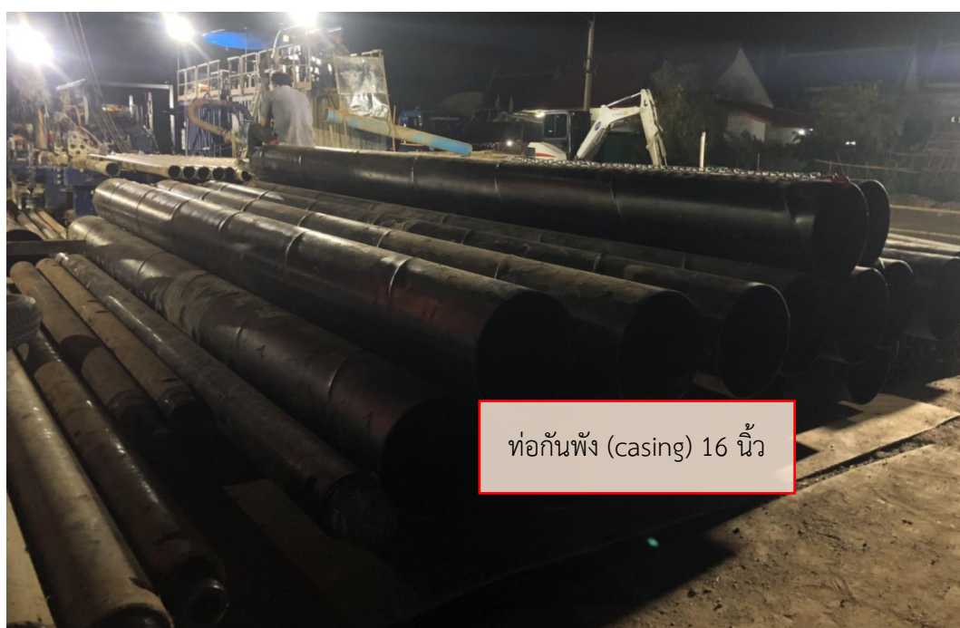
รูปที่ 4-42 ท่อกันพัง (casing) 20 นิ้ว และท่อกันพัง (casing) 16 นิ้ว
