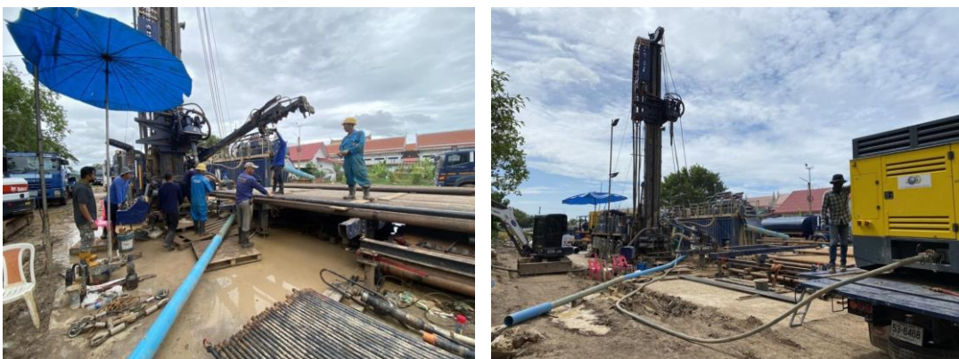
รูปที่ 4-75 การล้างตะกอนและน้ำโคลน
