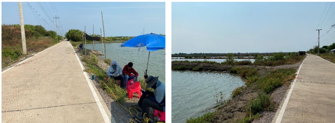
รูปที่ 4-22 สภาพพื้นที่แนวสำรวจ SK005
