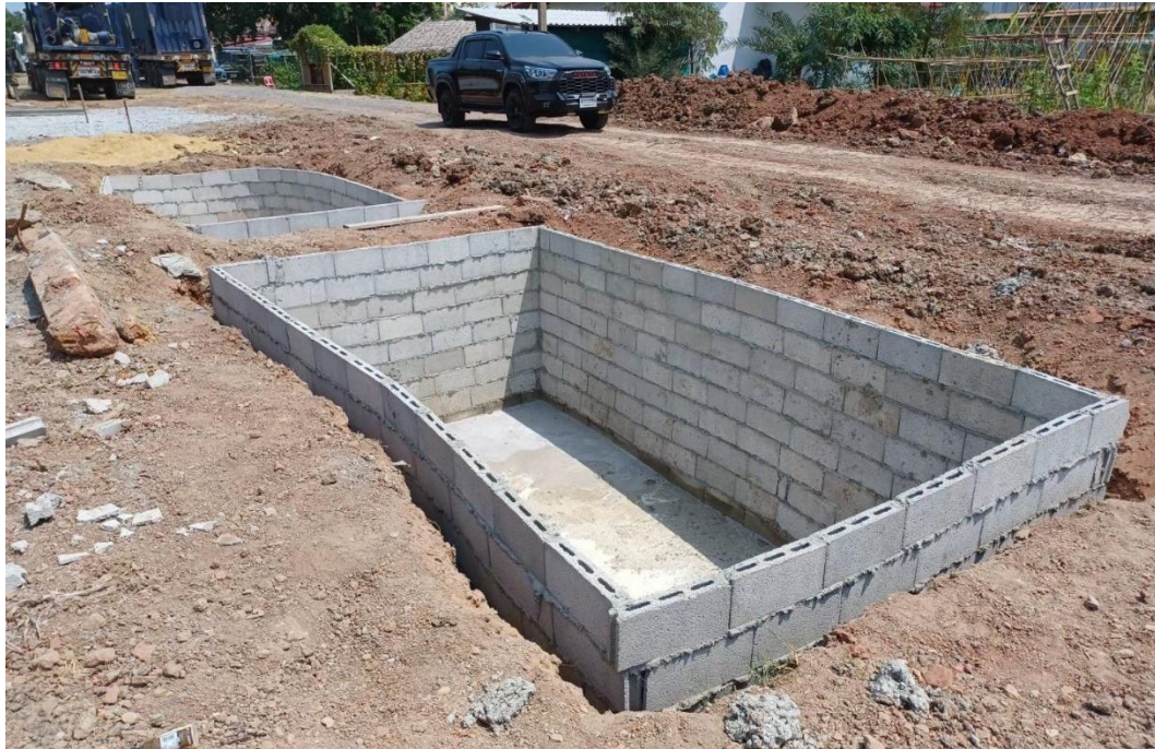
รูปที่ 4-45 การขุดเตรียมบ่อน้ำโคลน
