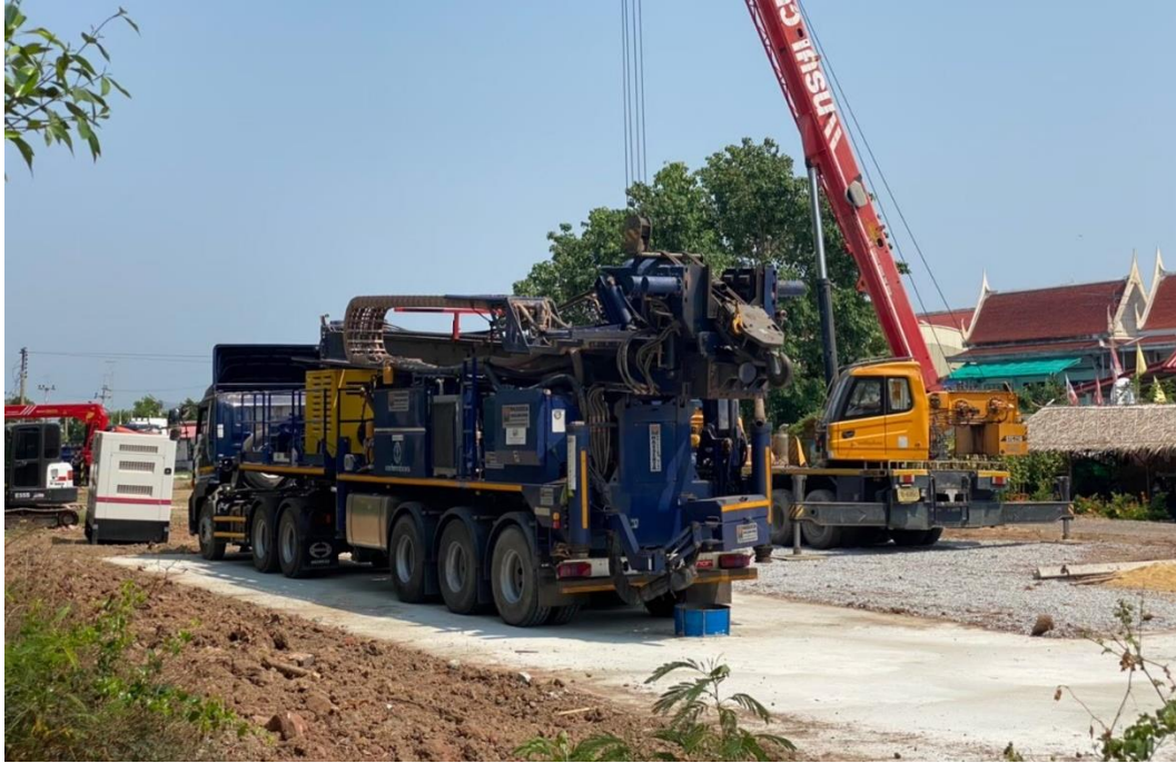
รูปที่ 4-44 ฐานรากเพื่อรองรับน้ำหนักรถเจาะ และอุปกรณ์
