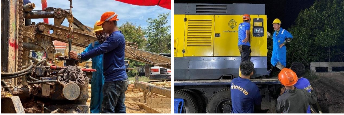
รูปที่ 4-68 ขั้นตอนการต่อท่อลม และอัดอากาศด้วยเครื่องอัดอากาศ
