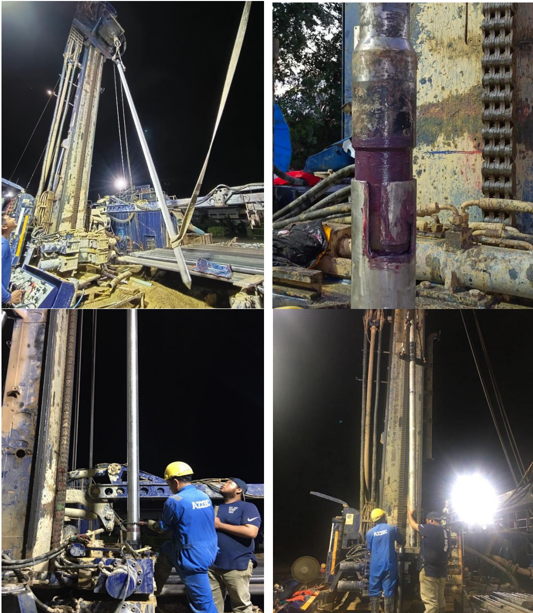
รูปที่ 4-74 การลงท่อกรองน้ำ (4-inc screen pipe) และท่อรับทราย (sand collector)
