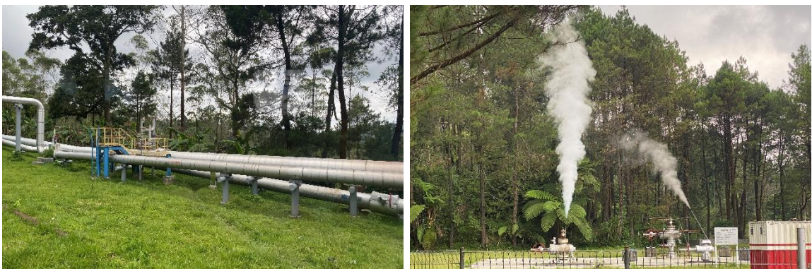
รูปที่ 16 บรรยากาศโดยรอบพื้นที่โรงไฟฟ้า
