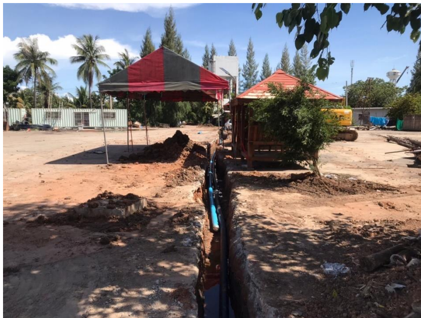
รูปที่ 4.6 การวางแนวท่อส่งน้ำ 1
