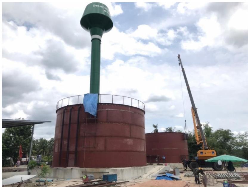
รูปที่ 4.2 การก่อสร้างระบบประปาบาดาล 2
