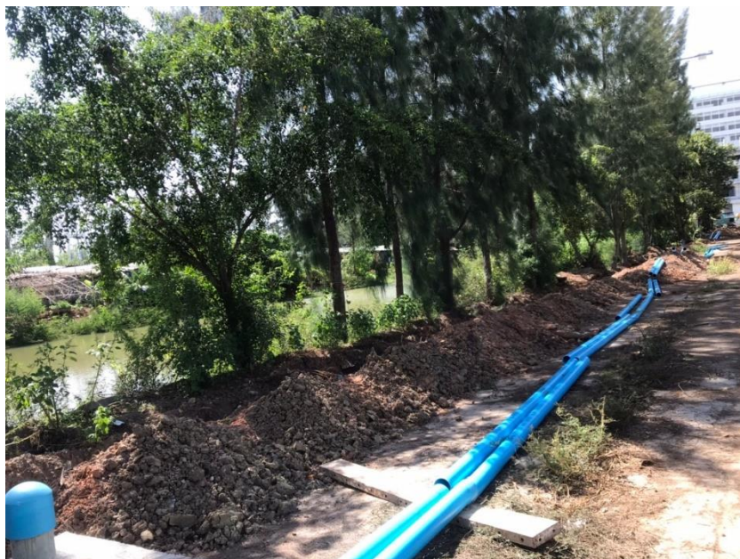
รูปที่ 4.8 การวางแนวท่อส่งน้ำ 3
