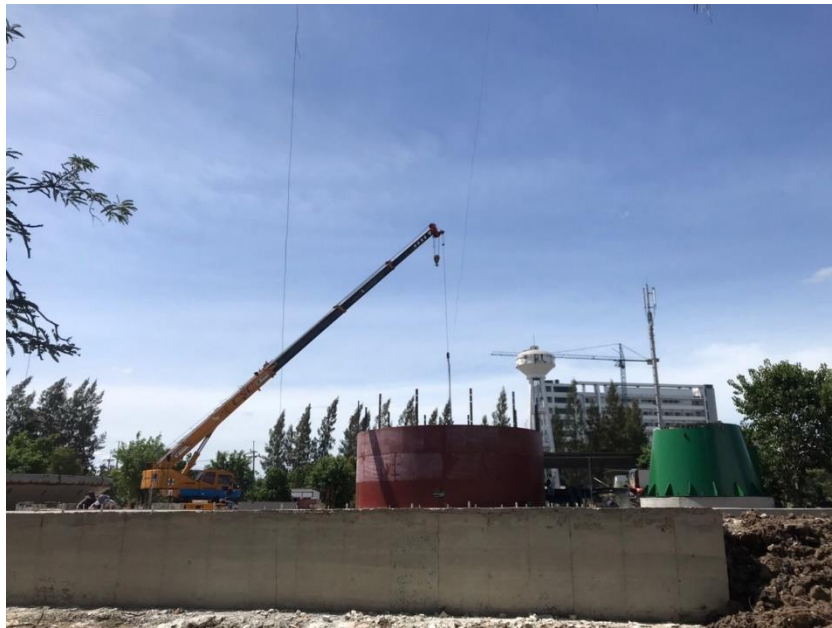
รูปที่ 4.1 การก่อสร้างระบบประปาบาดาล 1
