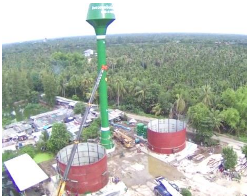
รูปที่ 4.4 การก่อสร้างระบบประปาบาดาล 4
