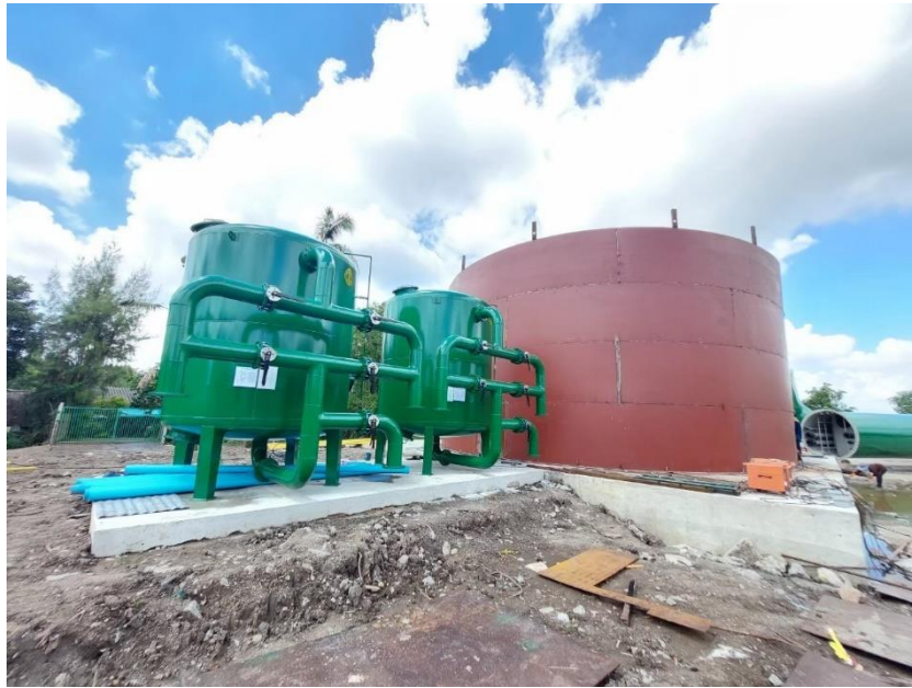
รูปที่ 4.3 การก่อสร้างระบบประปาบาดาล 3
