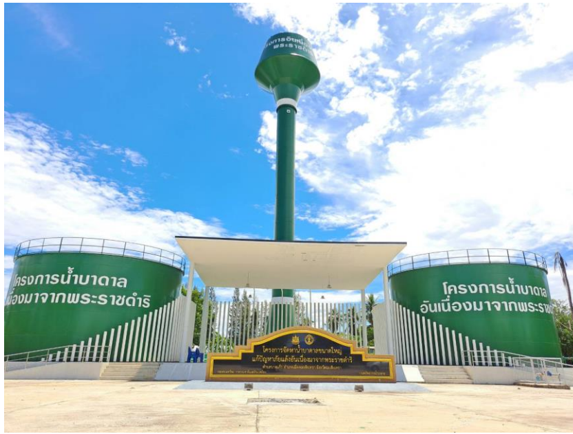
รูปที่ 4.5 การก่อสร้างระบบประปาบาดาลที่แล้วเสร็จ
