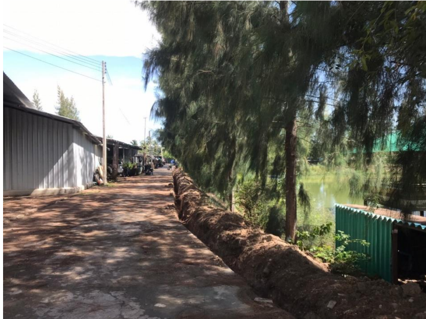
รูปที่ 4.7 การวางแนวท่อส่งน้ำ 2
