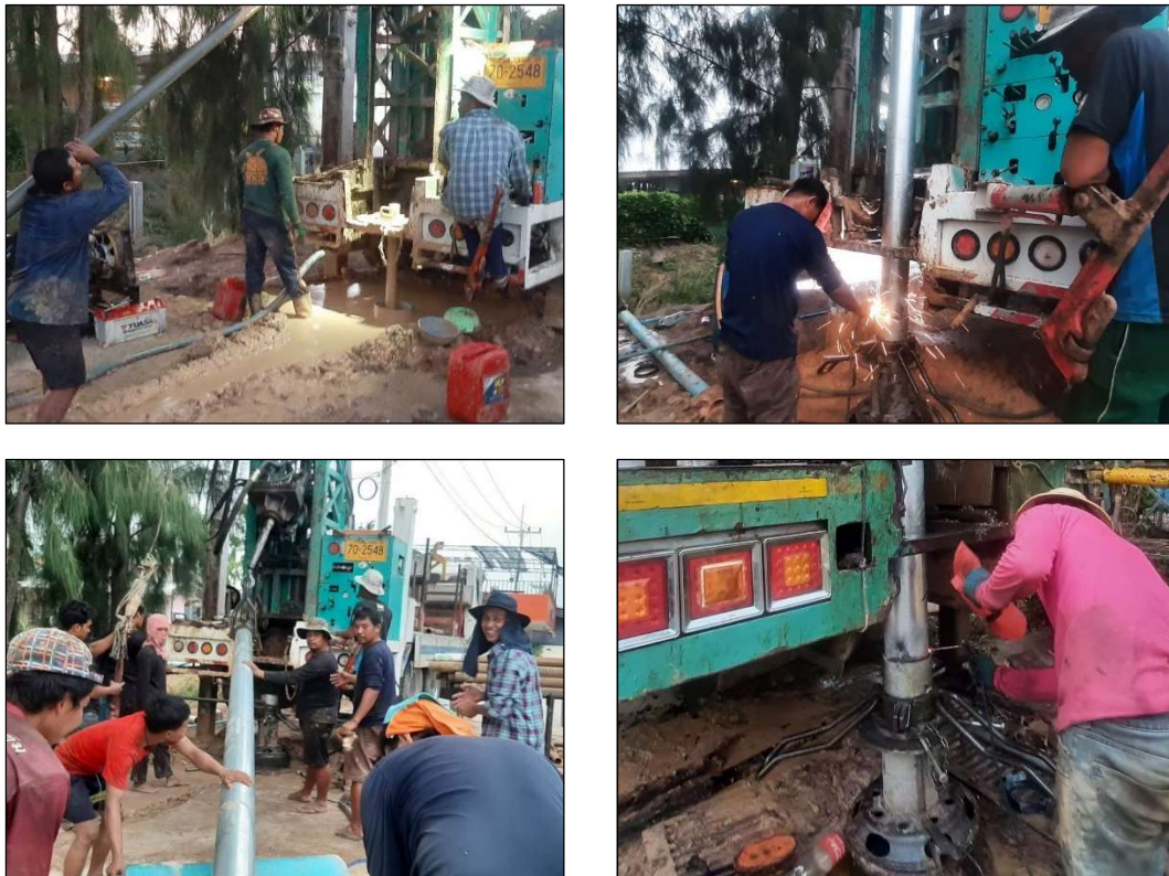
รูปที่ 3.1 การเจาะและพัฒนาบ่อน้ำบาดาล บริเวณ ต.บางแก้ว อ.เมืองฉะเชิงเทรา จ.ฉะเชิงเทรา
