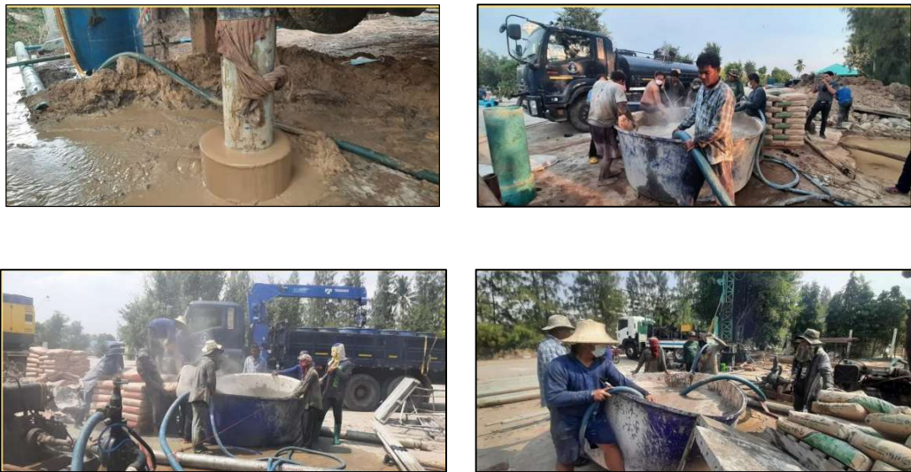
รูปที่ 3.2 การฉีกข้างบ่อด้วยซีเมนต์ บริเวณ ต.บางแก้ว อ.เมืองฉะเชิงเทรา จ.ฉะเชิงเทรา
