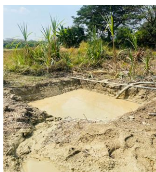
บ่อขุดบ่อน้ำโคลน
