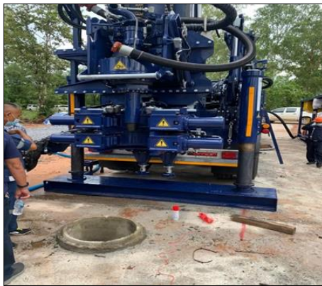
ข. ดำเนินการเจาะเปิดบ่อด้วยหัวเจาะ Down The Hole Hammer ขนาด 8 1 / 2 นิ้ว
