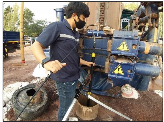
(ข) หย่อนหัววัดค่าบริเวณกลางหลุมเจาะ
