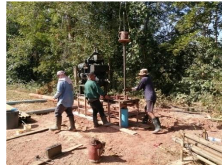
(ง) การติดตั้งเครื่องสูบน้ำบาดาล
