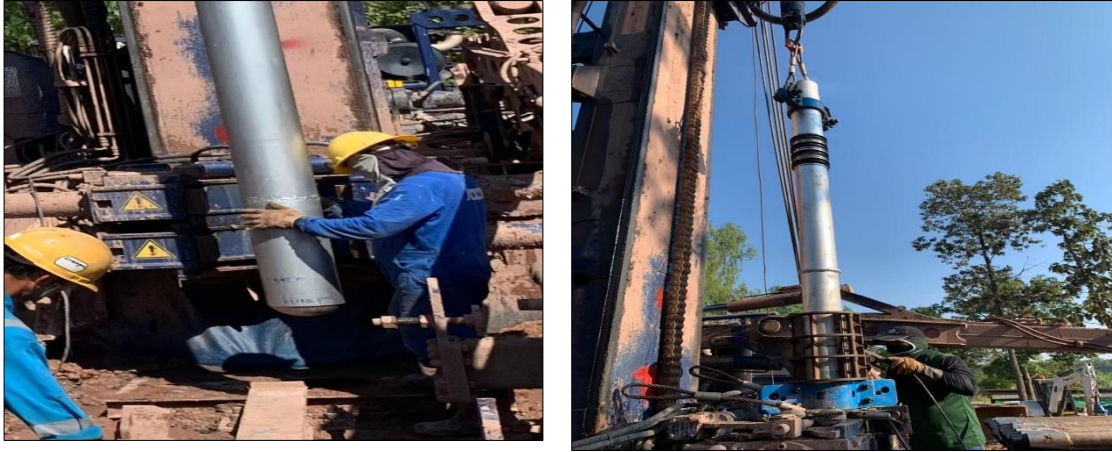
รูปที่ 4-41 ติดตั้งท่อกรูเหล็ก ขนาด 8 นิ้ว
