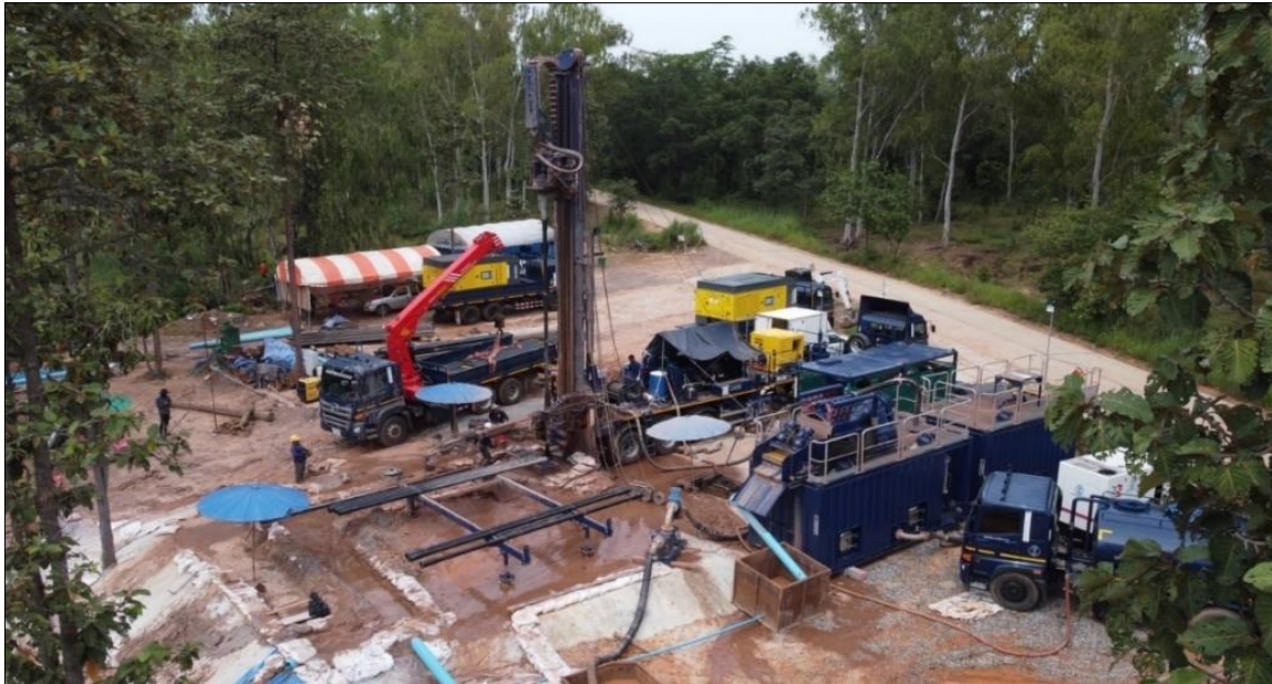
(ข) รถเจาะบ่อน้ำบาดาลระดับลึกพร้อมอุปกรณ์การเจาะ
