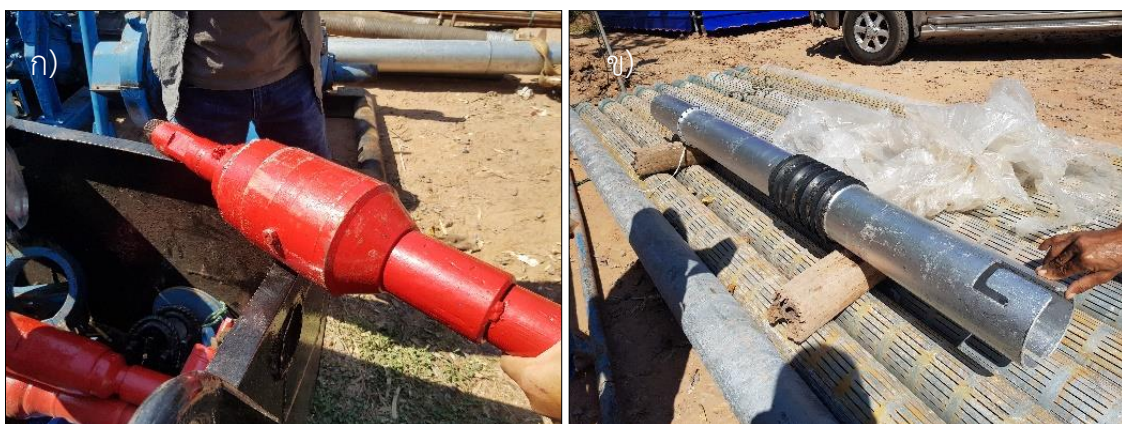
รูปที่ 4-46 (ก) อุปกรณ์ที่จะใช้ในการหย่อนท่อเจาะร่องและท่อรับทรายลงไปเพื่อติดตั้ง (ข) กรูขนาด 8 นิ้ว และชุดอุปกรณ์ที่ติดตั้งกับท่อกรู
