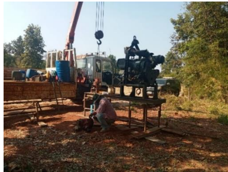
(ค) การติดตั้งเครื่องสูบน้ำบาดาล
