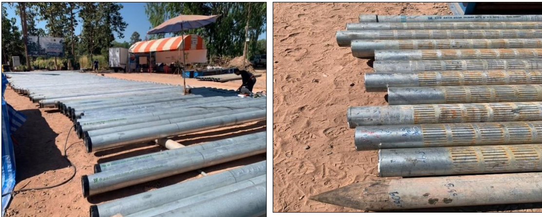
รูปที่ 4-40 ท่อกรู ท่อกรองหรือท่อเซาะร่อง
