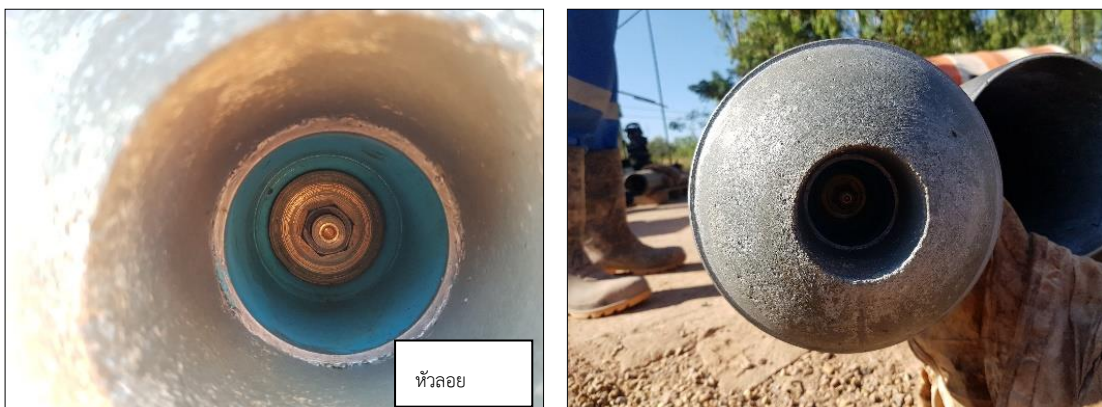
รูปที่ 4-42 การติดตั้งหัวลอย
