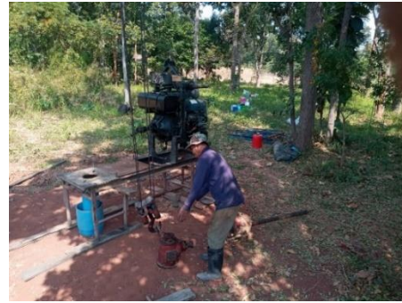
(ข) ติดตั้งอุปกรณ์เครื่องสูบน้ำ
