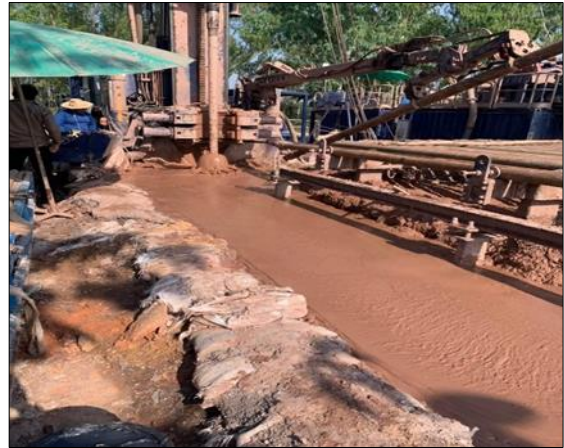
ฉ. เจาะสำรวจด้วยระบบน้ำโคลน หัวเจาะ Roller Rock Bit ขนาด 8 1/2 นิ้ว ที่ความลึก 870- 918 เมตร
