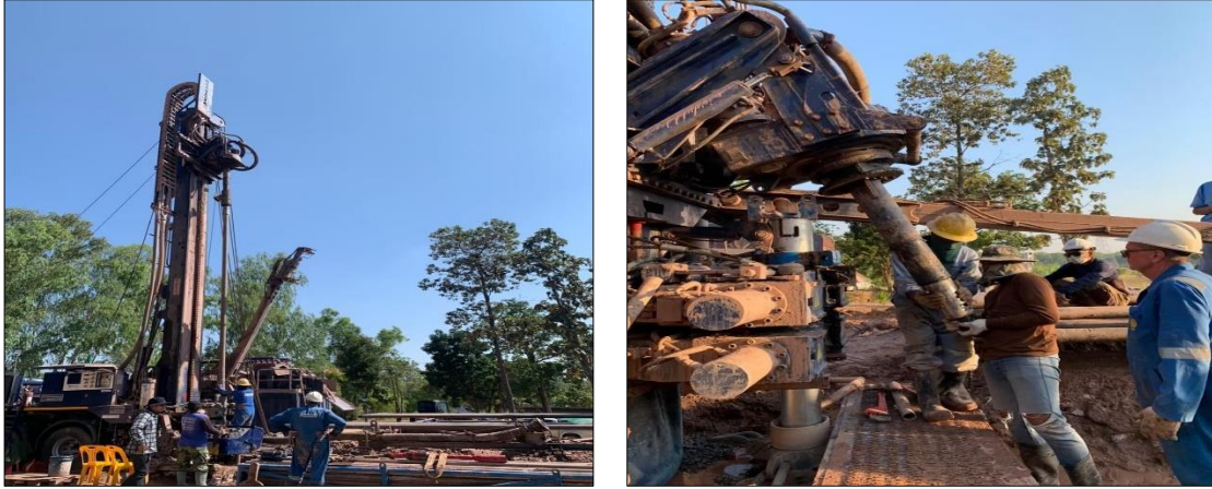
รูปที่ 4-45 อุปกรณ์ที่จะใช้ในการหย่อนท่อเจาะร่องและท่อรับทรายลงไปเพื่อติดตั้ง
