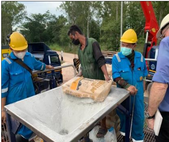
ง. ถอนก้านเจาะ จากนั้นเตรียมระบบน้ำโคลนเพื่อเจาะด้วยระบบน้ำโคลนต่อไป
