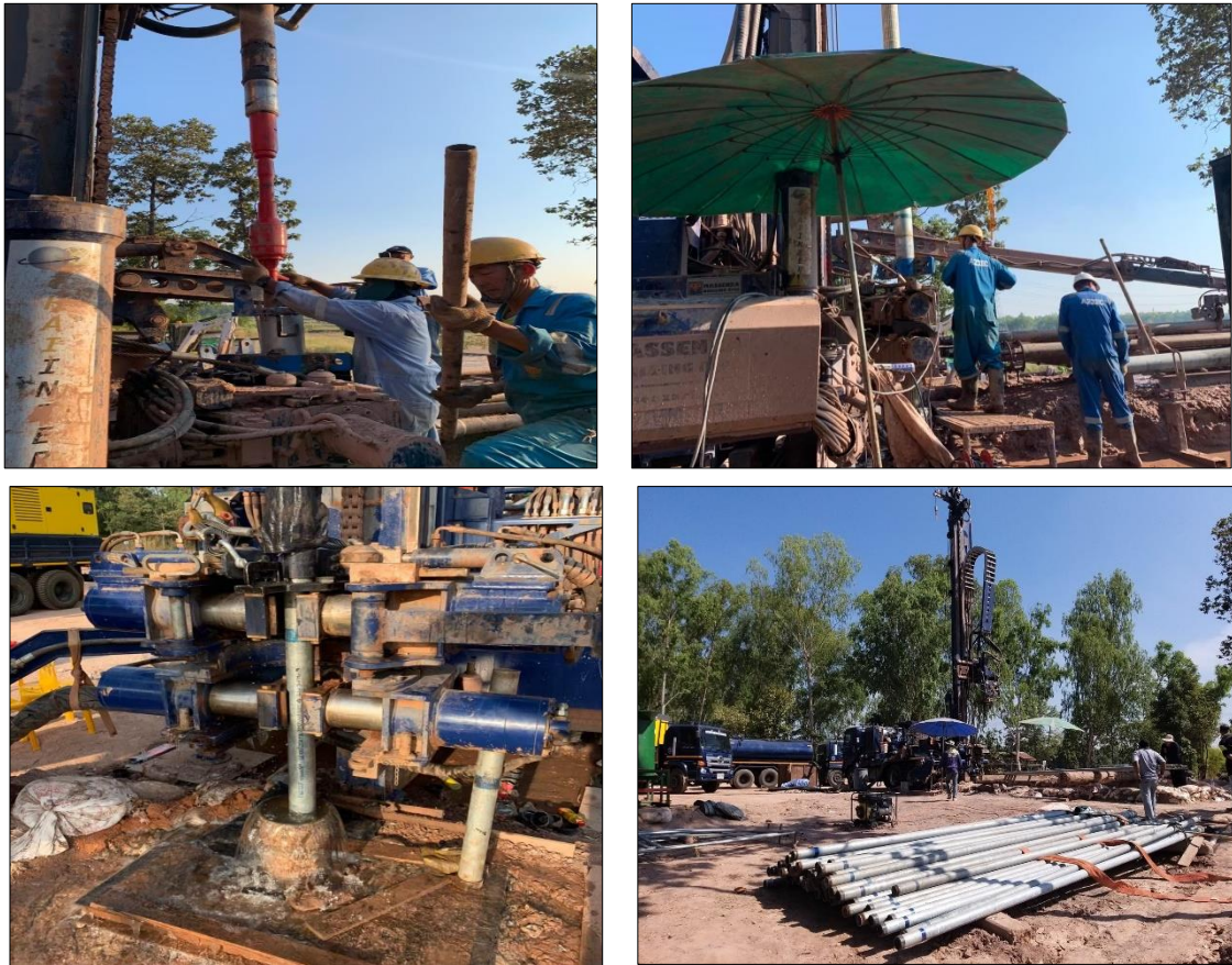
รูปที่ 4-47 การลงท่อกรงและท่อกรอง
