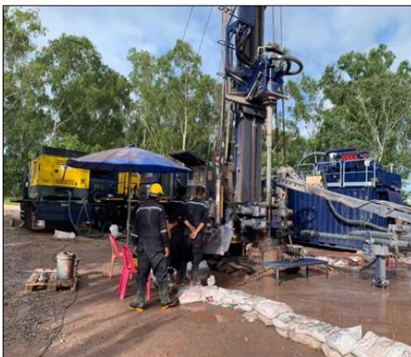
ค. เจาะขยายบ่อ ด้วยหัวเจาะ Drag Bit ขนาด 17 นิ้ว ความลึกที่ 0-18 เมตร เพื่อลงท่อกันพัง
