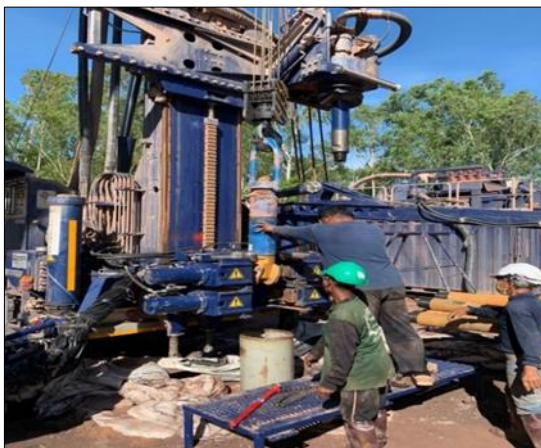
จ. เจาะสำรวจด้วยระบบน้ำโคลน หัวเจาะ PDC ขนาด 8 1/2 นิ้ว ที่ความลึก 600- 870 เมตร รูปที่ 4-28 (ก)-(ฉ) ขั้นตอนการเจาะน้ำบาดาลระดับลึก (ต่อ)
