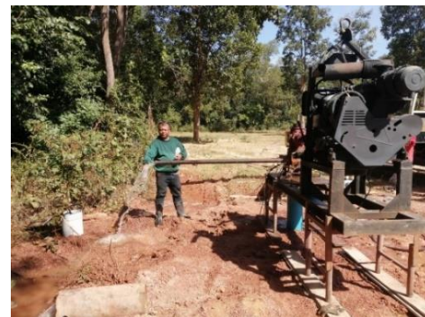
(ซ) ตรวจวัดระดับน้ำของบ่อสูบและบ่อ สังเกตการณ์
