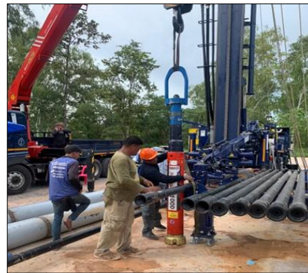
ข. ดำเนินการเจาะเปิดบ่อด้วยหัวเจาะ Down The Hole Hammer ขนาด 8 1 / 2 นิ้ว
