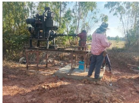
(จ) การติดตั้งเครื่องสูบน้ำบาดาลชนิดเทอร์ไบน์
