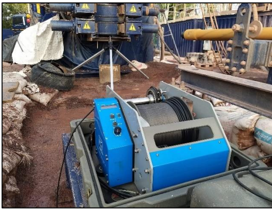
(ก) ติดตั้งรอกสามขาบริเวณเหนือปากหลุมเจาะ
