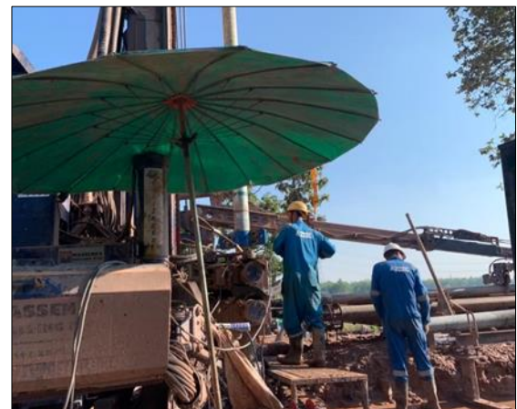
จ. เจาะสำรวจด้วยระบบน้ำโคลน หัวเจาะ PDC ขนาด 8 1/2 นิ้ว ที่ความลึก 600- 870 เมตร รูปที่ 4-28 (ก)-(ฉ) ขั้นตอนการเจาะน้ำบาดาลระดับลึก (ต่อ)
