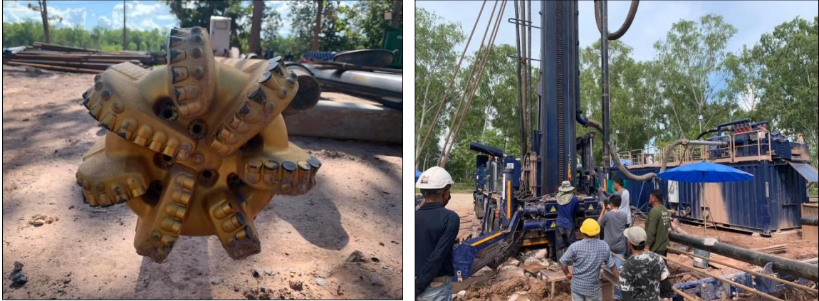
รูปที่ 4-39 เจาะขยายบ่อด้วยระบบน้ำโคลน
