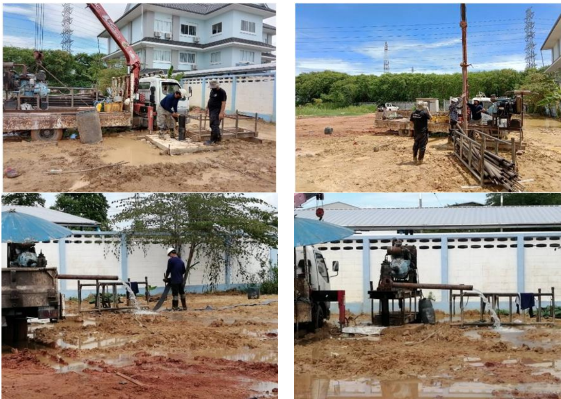
รูปที่ 3-15 การสูบทดสอบปริมาณน้ำในบ่อสังเกตการณ์ ทั้ง 3 บ่อ
