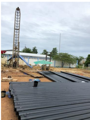
รูปที่ 3-2 ท่อกรูบ และท่อกรอง ประเภท ท่อเหล็ก API 5L/ASTM A53
