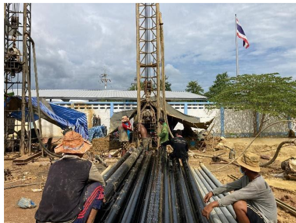
รูปที่ 3-2 ท่อกรูบ และท่อกรอง ประเภท ท่อเหล็ก API 5L/ASTM A53
