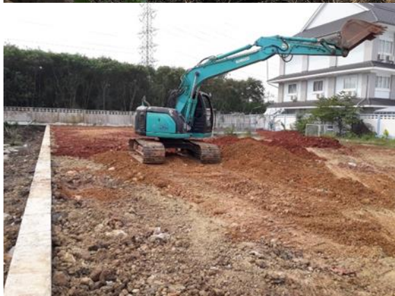
รูปที่ 4-10 ภาพแสดงการปฏิบัติงานถมดิน ปรับระดับความสูงของพื้นที่ พร้อมกำแพงกันดินที่สามารถ ป้องกันการสไลด์ของดินด้านข้าง
