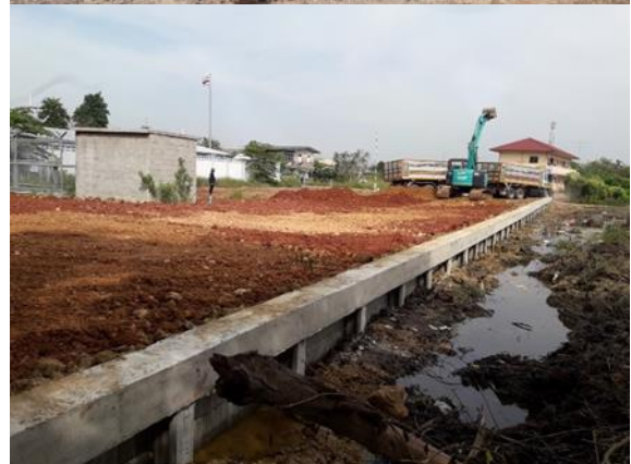
รูปที่ 4-10 ภาพแสดงการปฏิบัติงานถมดิน ปรับระดับความสูงของพื้นที่ พร้อมกำแพงกันดินที่สามารถ ป้องกันการสไลด์ของดินด้านข้าง
