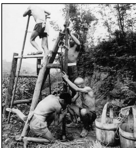
การเจาะบ่อน้ำบาดาลในสมัย North Song Dynasty (960-1127 AD). (from Zhong & Huang)
