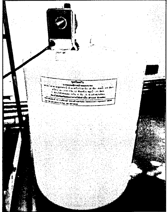
๑.๖ ระบบป้องกันการตกผลึกหน้าเมมเบรน จำนวน ๑ ชุด
