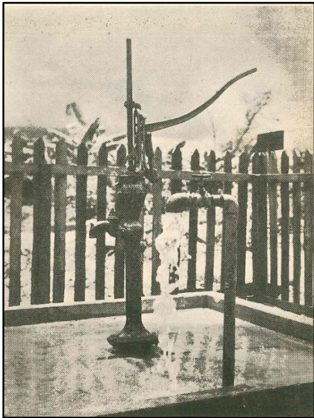
การติดตั้งเครื่องสูบน้ำมือโยก
