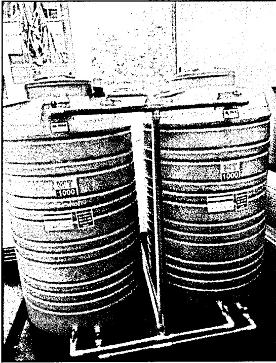
๑.๑ ถังบรรจุน้ำดิบ จำนวน ๒ ถัง
