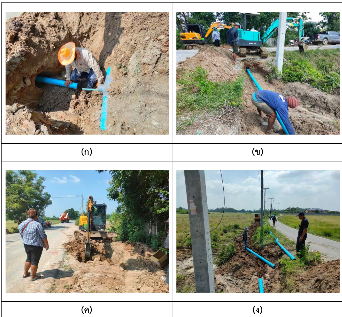
ภาพที่ 4- 8 (ก-ง) งานเดินท่อกระจายน้ำ ของระบบส่งน้ำบาดาลระยะไกล บ้านหนองศาลา หมู่ที่ 3
