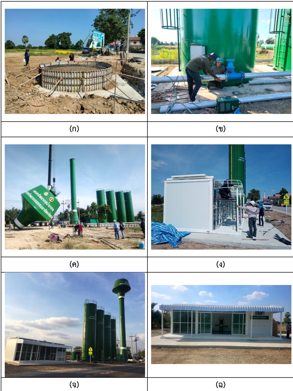
ภาพที่ 4- 13 (ก-ฉ) งานก่อสร้างระบบส่งน้ำบาดาลระยะไกล บ้านหนองแวง หมู่ที่ 4
