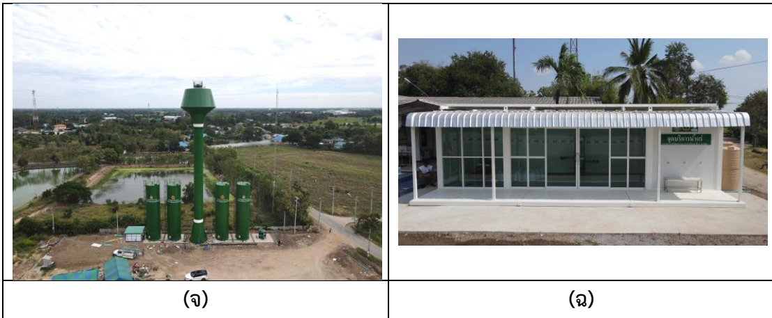
ภาพที่ 4- 7 (ก-ฉ) งานก่อสร้างระบบส่งน้ำบาดาลระยะไกล บ้านหนองศาลา หมู่ที่ 3
