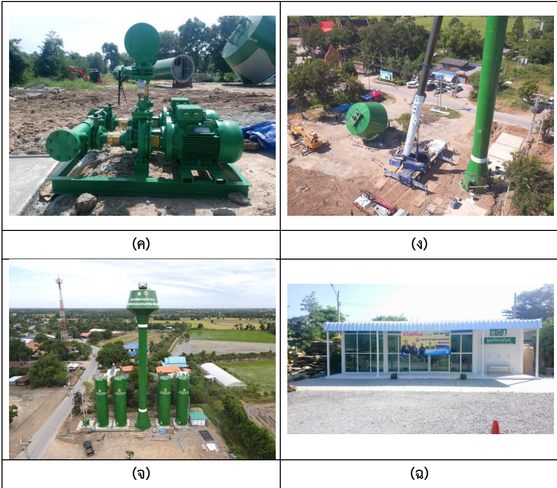
ภาพที่ 4- 10 (ก-ฉ) งานก่อสร้างระบบส่งน้ำบาดาลระยะไกล บ้านหนองบัว หมู่ที่ 7
