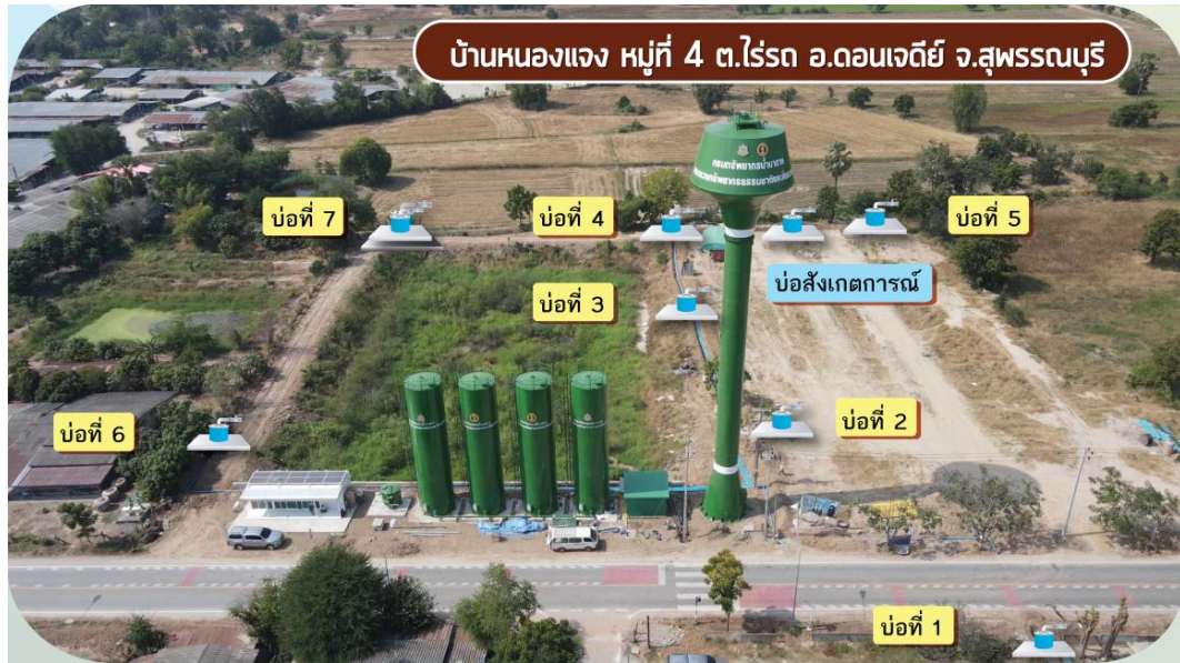
ภาพที่ 4- 15 ระบบส่งน้ำบาดาลระยะไกล พร้อมตำแหน่งบ่อน้ำบาดาลในระบบ บ้านหนองแจง หมู่ที่ 4
