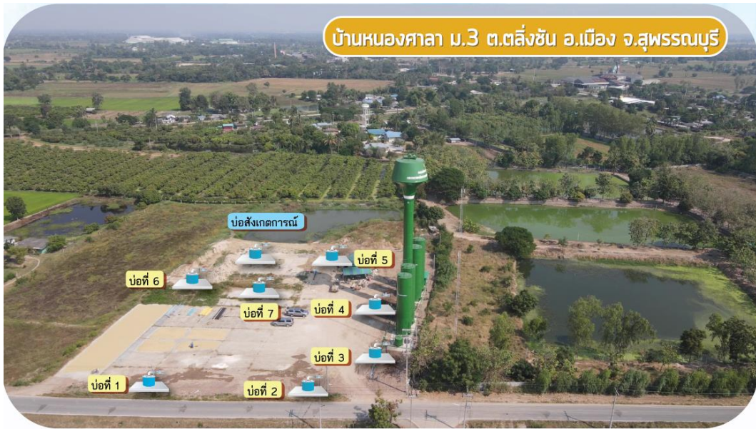
ภาพที่ 4- 9 ระบบส่งน้ำบาดาลระยะไกล พร้อมตำแหน่งบ่อน้ำบาดาลในระบบ บ้านหนองศาลา หมู่ที่ 3
