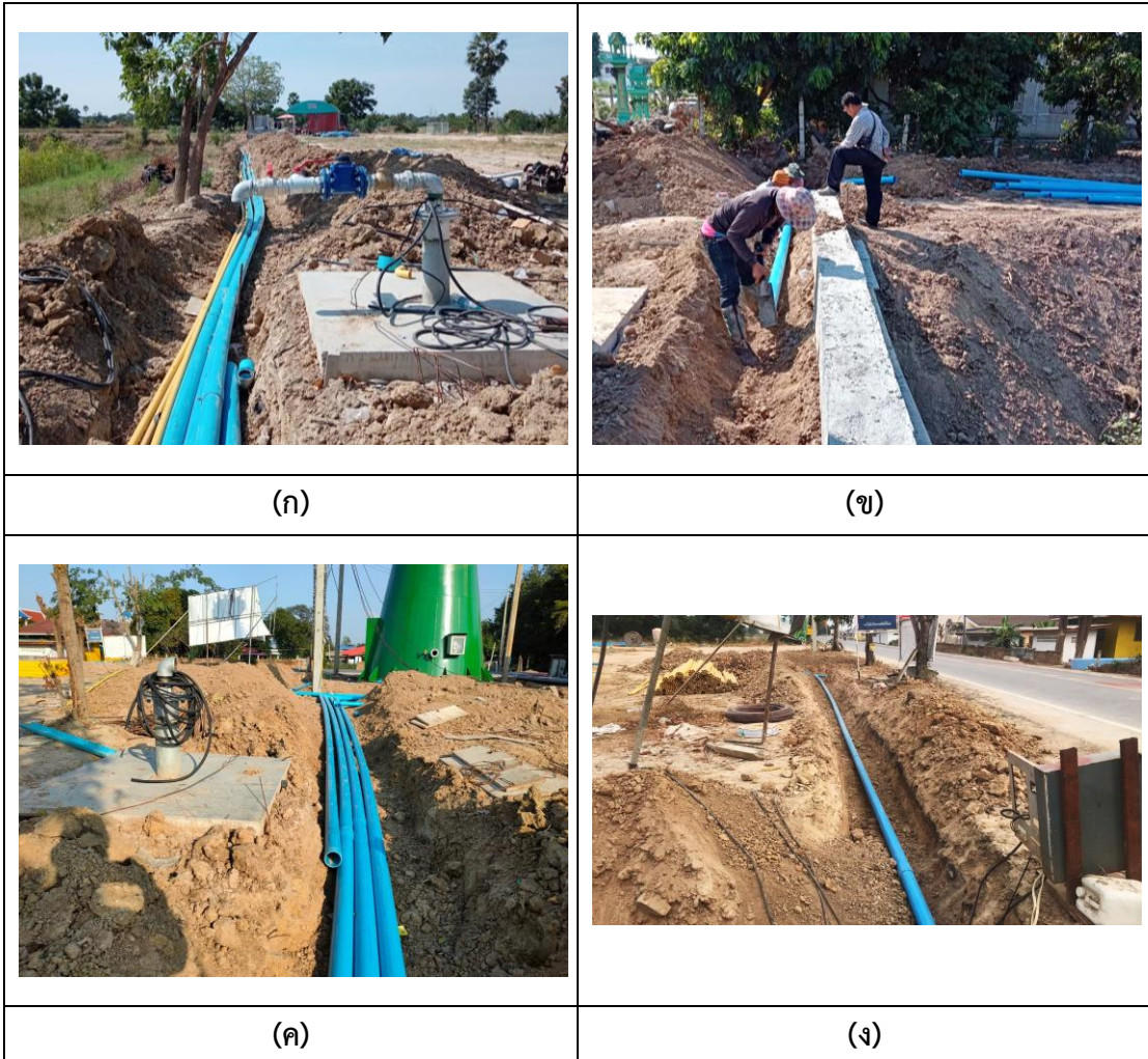
ภาพที่ 4- 14 (ก-ง) งานเดินท่อกระจายน้ำ ของระบบส่งน้ำบาดาลระยะไกล บ้านหนองแวง หมู่ที่ 4
