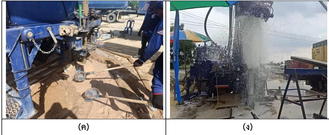
ภาพที่ 3- 11 (ก-ง) ตัวอย่างเครื่องจักรเจาะน้ำบาดาลที่ใช้ในการดำเนินโครงการฯ
