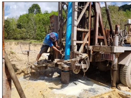
รูปที่ 3.17 การเจาะน้ำบาดาลและพัฒนาบ่อน้ำบาดาล บริเวณ ต.สนาบไชย อ.นายายอาม จ.จันทบุรี
