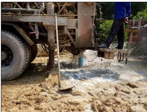
รูปที่ 3.17 การเจาะน้ำบาดาลและพัฒนาบ่อน้ำบาดาล บริเวณ ต.สนาบไชย อ.นายายอาม จ.จันทบุรี
