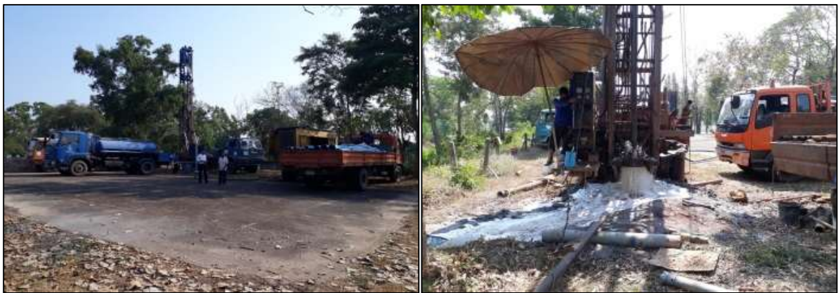
รูปที่ 3.6 การเจาะบ่อน้ำบาดาล
