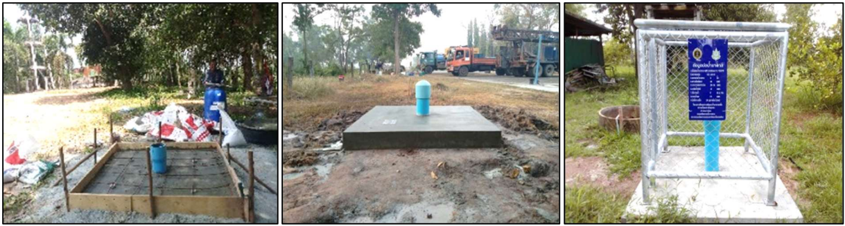
รูปที่ 3.10 การก่อสร้างขานบ่อและล้อมรั้วรอบบ่อน้ำบาดาล
