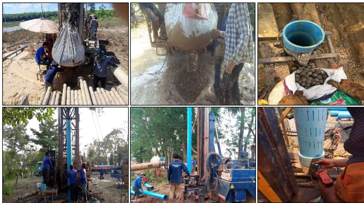
รูปที่ 3.8 การลงกรวดกรูบ และการลงท่อกรูบ
