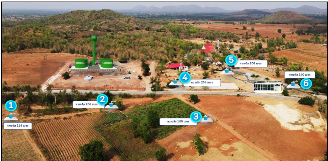
ภาพที่ 4- 18 ตำแหน่งบ่อผลิตในระบบประปาบาดาลฯ บํานพยอมงาม หมู่ที่ 12
