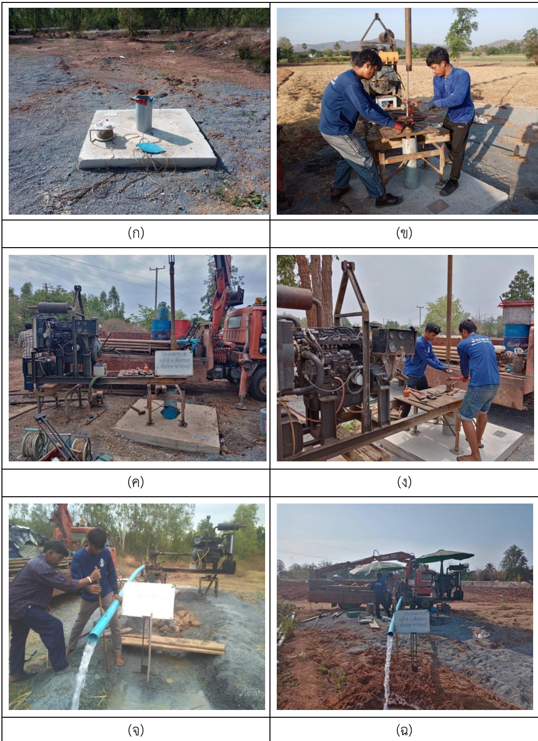
ภาพที่ 3- 23 ภาพแสดงขั้นตอนการปฏิบัติงานสูบทดสอบปริมาณบํานานํ้าบาดาลในภาคสนาม บ้านทุ่งคูณ หมู่ 19 ตำบลห้วยกระเจา อำเภอห้วยกระเจา จังหวัดกาญจนบุรี
