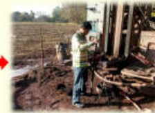
ห้อยธรณีหลุมเจาะบ่อเจาะสำรวจ
