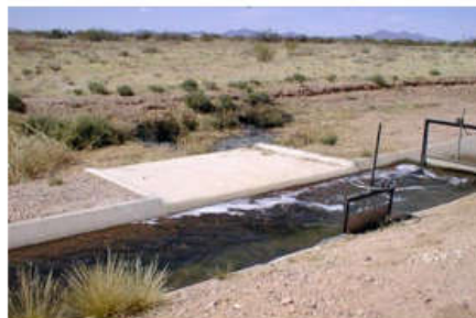
ประตูปรับน้ำที่ใช้ผันน้ำเข้าพื้นที่โครงการ
