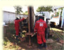
เจาะบ่อสำรวจและพัฒนาพบน้ำบาดาล
