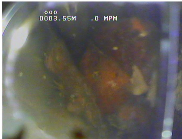
สภาพก้นบ่อ
