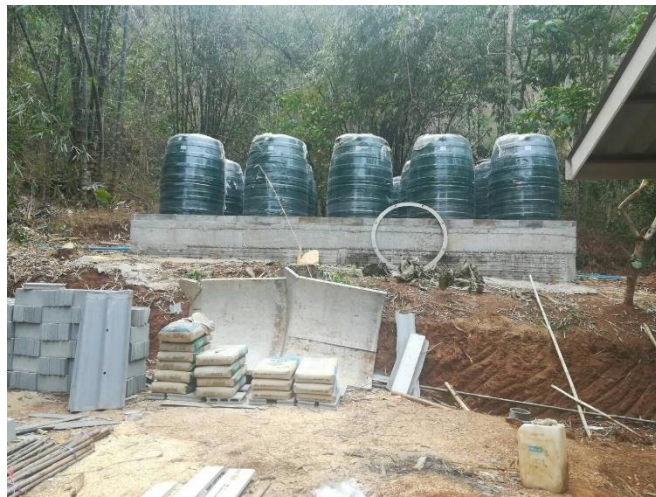
รูปที่ 4-50 ขั้นตอนการก่อสร้างระบบประปาบาดาล และระบบปรับปรุงคุณภาพน้ำบาดาล
