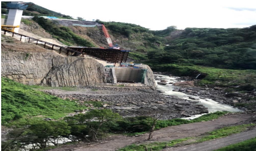
รูปที่ 19 การสร้างเขื่อนชะลอน้ำในบริเวณภูเขา
