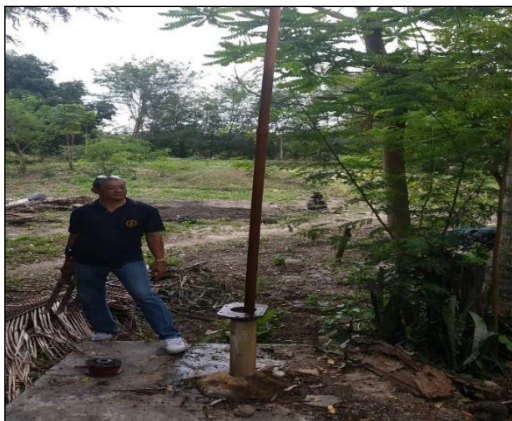
รูปที่ 3-5 การติดตั้งท่อสูบน้ำ (eductor pipe)
