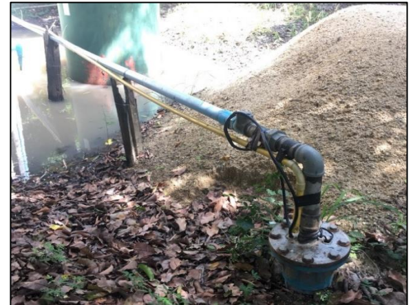
รูปที่ 3-1 สภาพบ่อบ่อบาดาล และเครื่องสูบน้ำ
