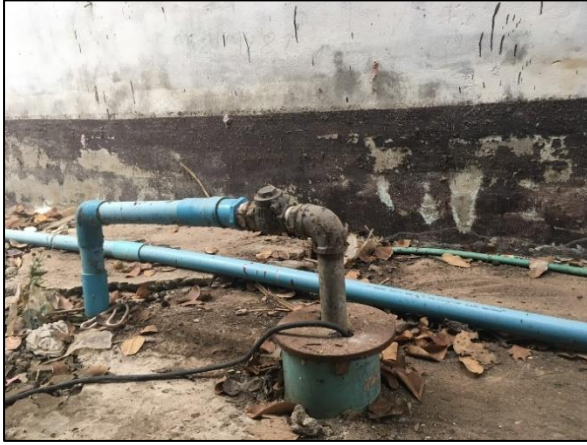
รูปที่ 3-1 สภาพบ่อบ่อบาดาล และเครื่องสูบน้ำ
