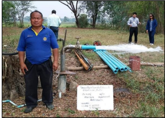
รูปที่ 3-6 การเป่าล้างบ่อน้ำบาดาล
