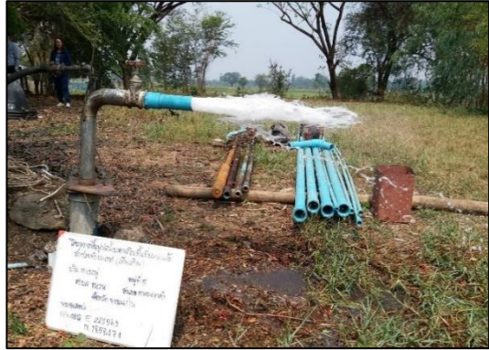
รูปที่ 3-6 การเป่าล้างบ่อน้ำบาดาล
