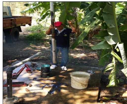
รูปที่ 3-5 การติดตั้งท่อสูบน้ำ (eductor pipe)
