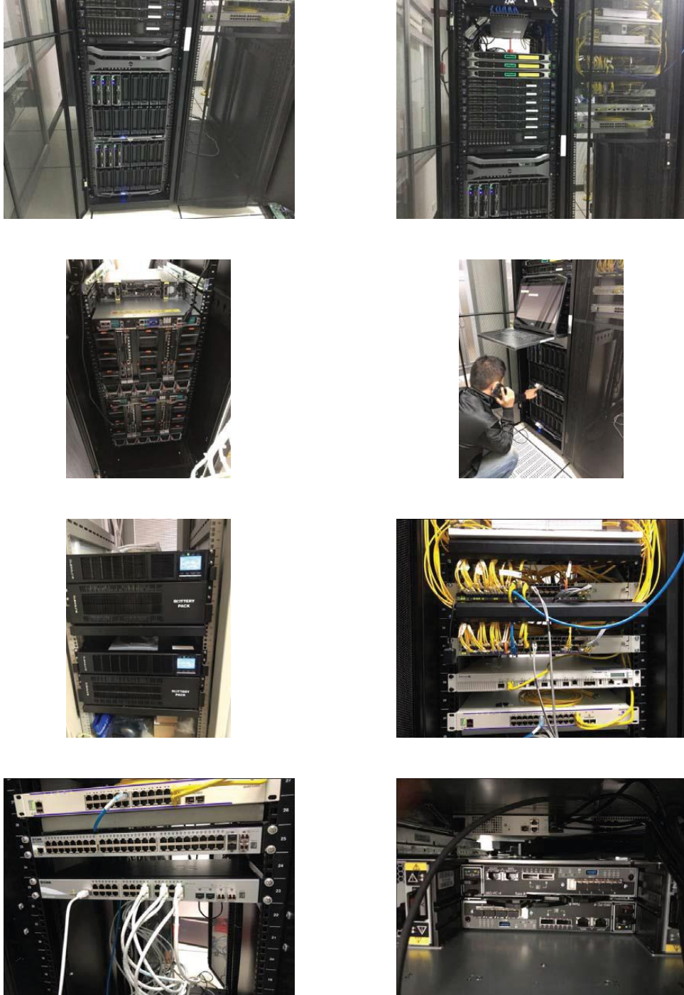
รูปที่ 3.9 การติดตั้งอุปกรณ์การประมวลผล
