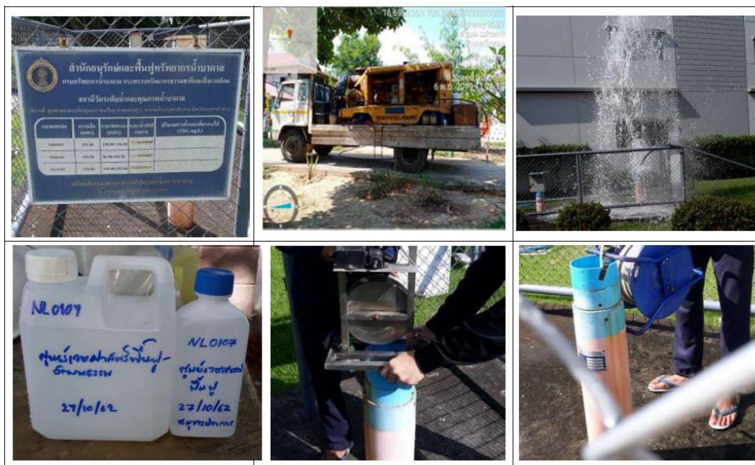
รูปที่ 4.3 การเป่าล้างบ่อสังเกตการณ์น้ำบาดาล
