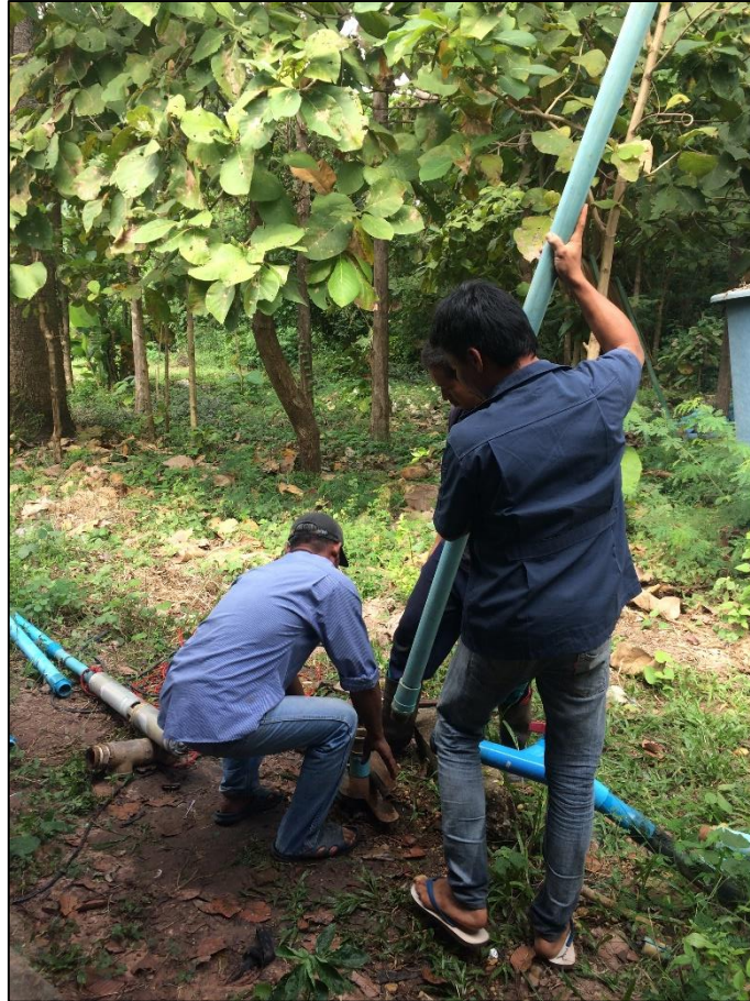
รูปที่ 3-4 การถอนชุดเครื่องสูบน้ำขึ้นจากบ่อน้ำบาดาล ตรวจสอบวัดความลึกบ่อน้ำบาดาล และวัดระดับน้ำ
