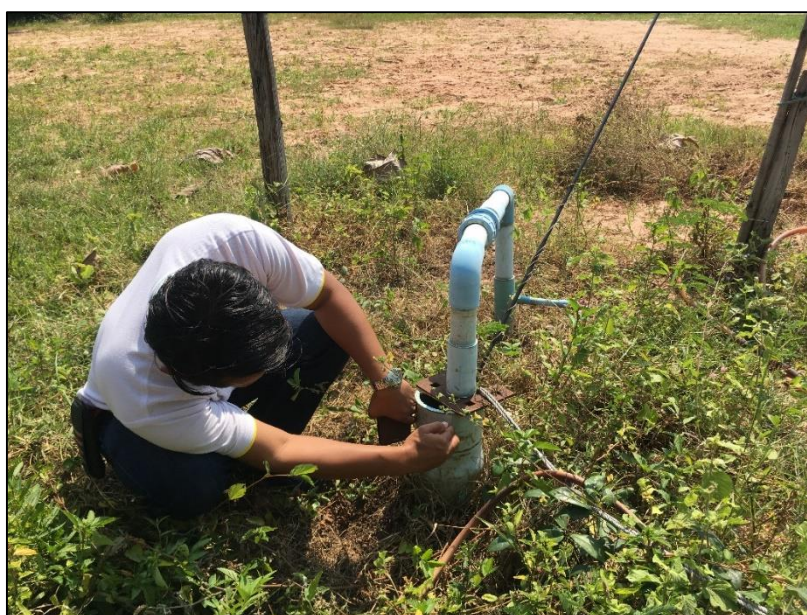
รูปที่ 3-2 การตรวจสอบสภาพบ่อน้ำบาดาล และเครื่องสูบน้ำ
