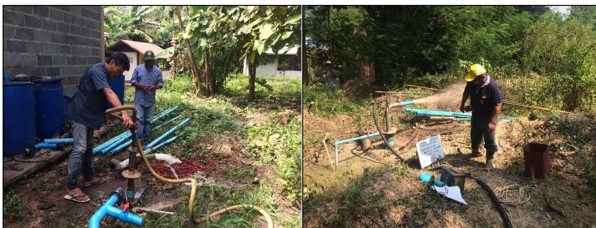
รูปที่ 3-6 การเป่าล้างบ่อน้ำบาดาล
