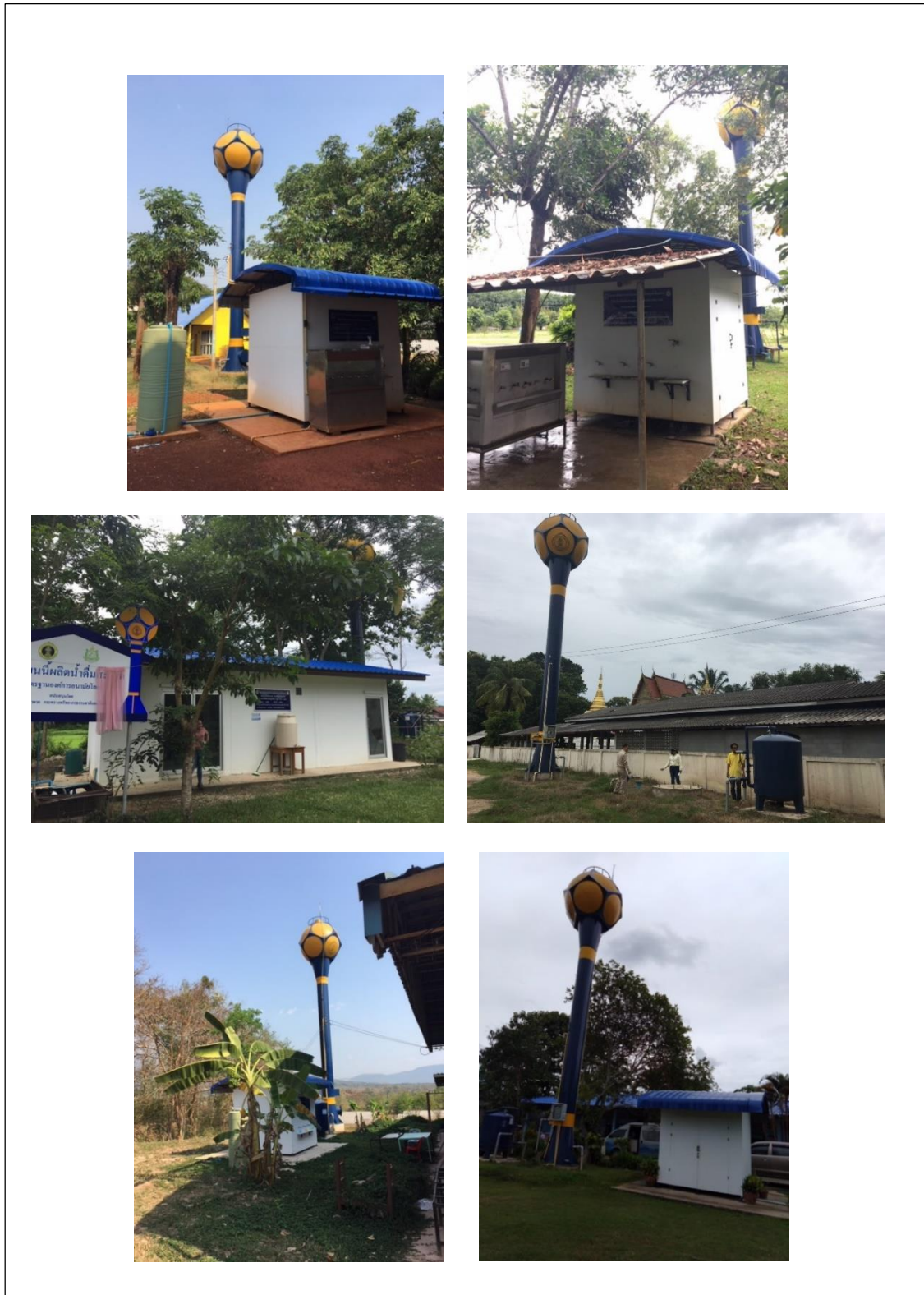
รูปแบบน้ำโรงเรียนที่ก่อสร้างโดยกรมทรัพยากรน้ำบาดาล
