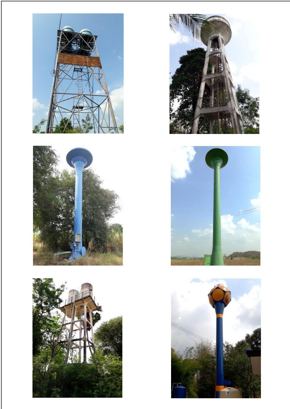
การสำรวจระบบประปาบาดาล
