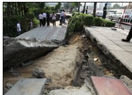
ภาพการทรุดตัวของแผ่นดิน มีความยาวมากกว่า 20 เมตร และมีความลึกประมาณ 3 เมตร ในเมืองไถโจว เมืองเจ้อเจียง ซึ่งเป็นสาเหตุทำให้ท่อน้ำที่อยู่ใต้ดินเกิดความเสียหาย
