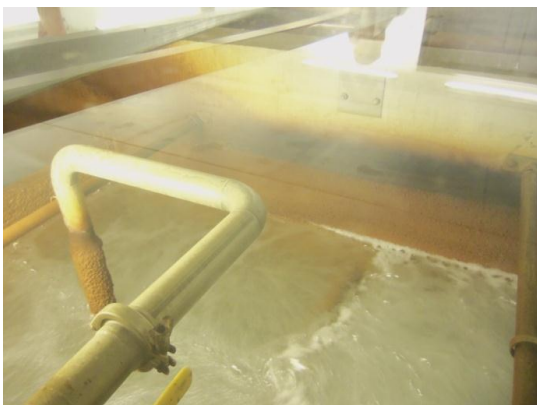
รูปที่ 11. การเติมอากาศเพื่อเร่งการตกตะกอนเหล็กและมันганиส
