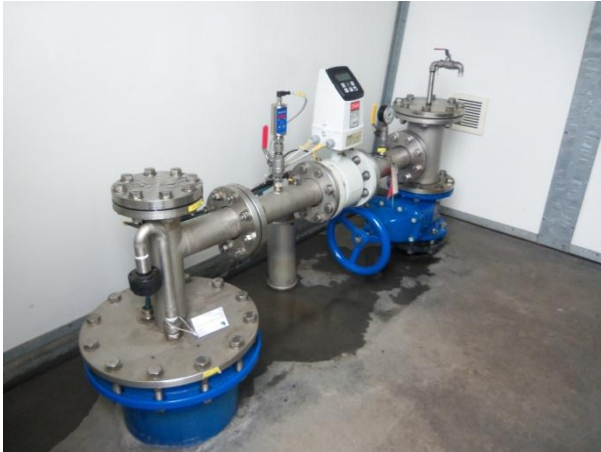
รูปที่ 8. ลักษณะบ่อผลิต มีจุดเก็บตัวอย่างน้ำก่อนเข้าสู่ระบบผลิตประปา
