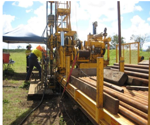
รูปที่ 4 แสดงแท่นเจาะบ่อน้ำบาดาลและก้าน
