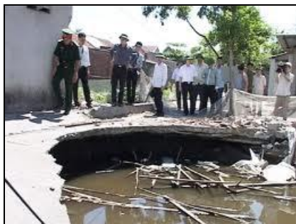
ภาพการทรุดตัวของแผ่นดิน มีความยาวมากกว่า 20 เมตร และมีความลึกประมาณ 3 เมตร ในเมืองไถโจว เมืองเจ้อเจียง ซึ่งเป็นสาเหตุทำให้ท่อน้ำที่อยู่ใต้ดินเกิดความเสียหาย
