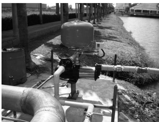
รูปการติดตั้งปั๊มเพื่อปัมน้ำจากสระน้ำ
