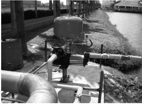
การติดตั้งปั๊มเพื่อปัมน้ำจากสระน้ำ
