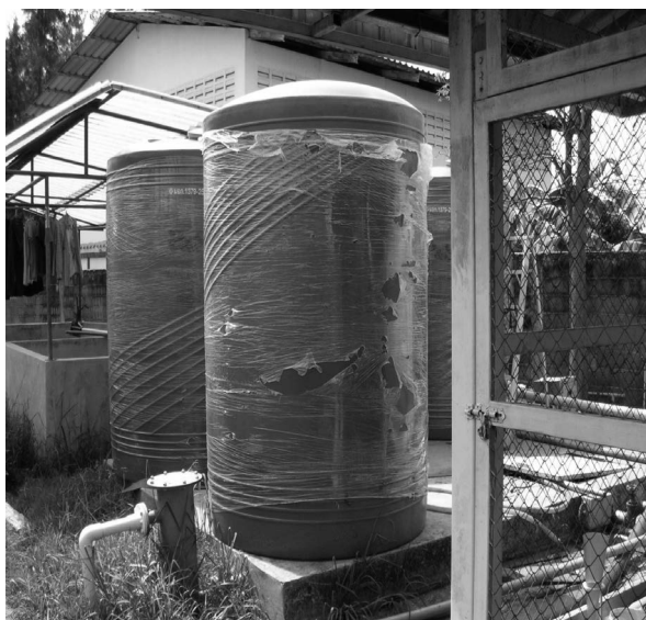
ก) ถังพักน้ำจากระบบบำบัด
