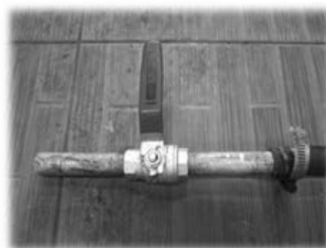
รูปที่ D3.2 การติดตั้งหัวฉีดที่ปลายท่อน้ำล้างพื้นในส่วนโรงมารีนโปรตีน
