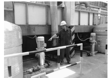
รูป การติดตั้งระบบฉีดน้ำแรงดันสูงหลังการปรับปรุง
