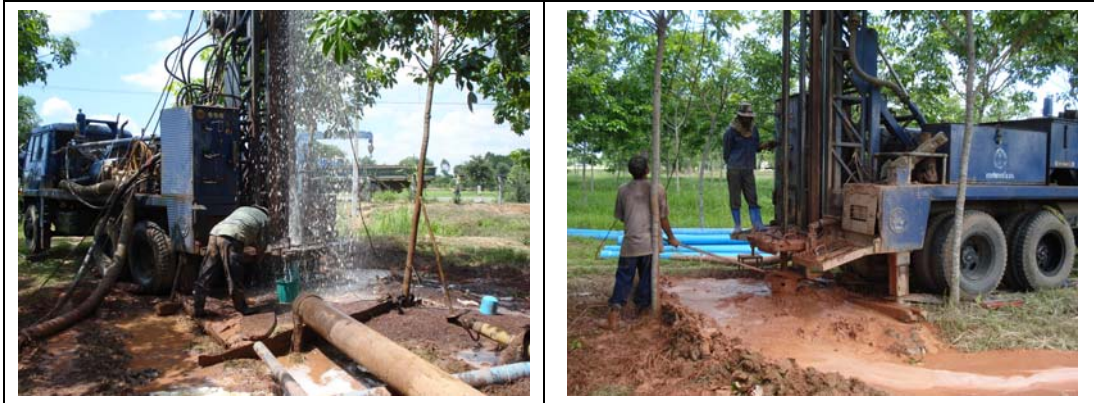
รูปที่ 3-5 การเจาะบ่อน้ำบาดาล
