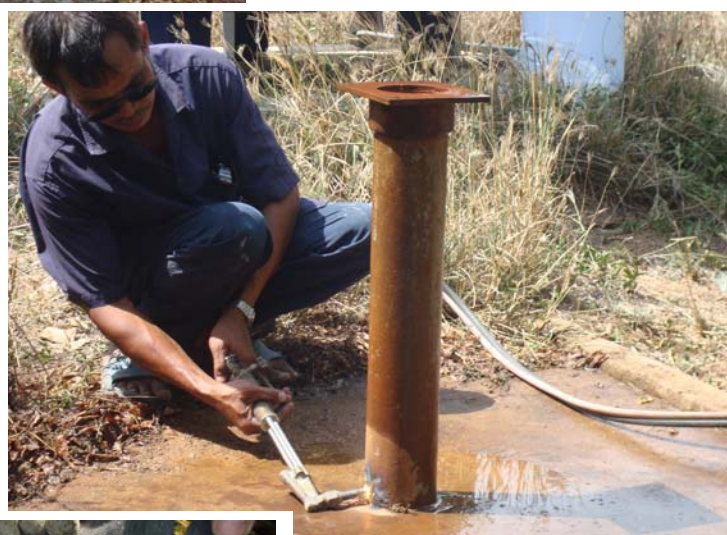
ตัดท่อกรูบ่อให้เสมอพื้นดิน
