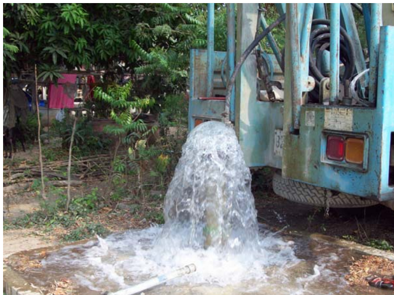
การเป่าล้างบ่อน้ำบาดาล
