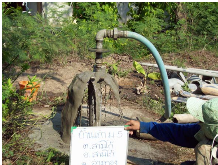
การอัดปูนซีเมนต์ลงในบ่อน้ำบาดาล
