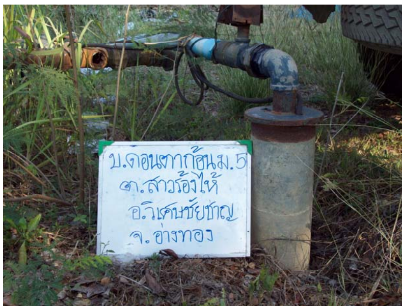
ก่อนเข้าดำเนินการอุดกลบ่อน้ำบาดาล ด้วยปูนซีเมนต์
