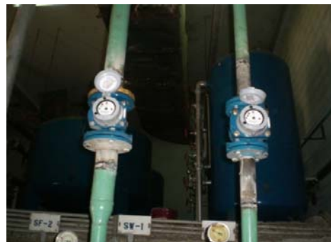
มิเตอร์น้ำ SOFT จ่ายเข้าโรงงาน BDT, BWM 4
