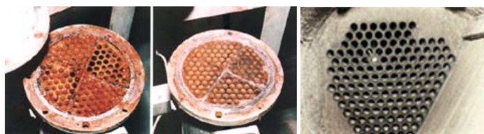
สภาพก่อน-หลัง ของ Condenser
