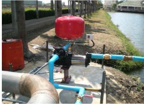
การติดตั้งบ่อบีเอ็มเพื่อบิมน้ำจากสระน้ำ
