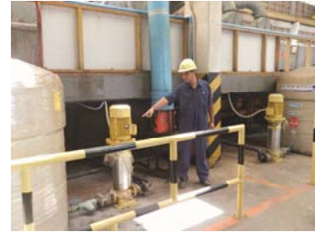
รูป การติดตั้งระบบฉีดน้ำแรงดันสูงแบบไฮเจ็ตหลังการปรับปรุง
