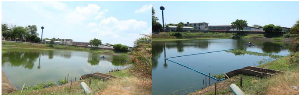
บ่อเก็บน้ำฝน
