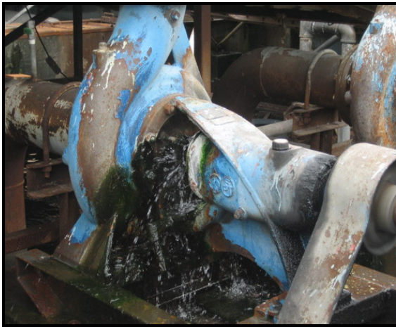
ภาพก่อนปรับปรุง
