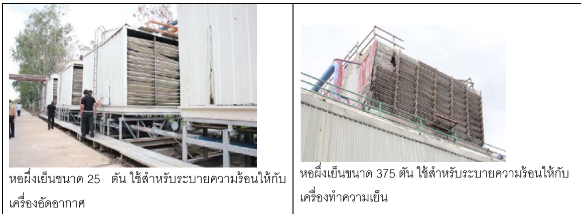
รูปที่ A2.7 หอผึ่งเย็นของทางโรงงาน
