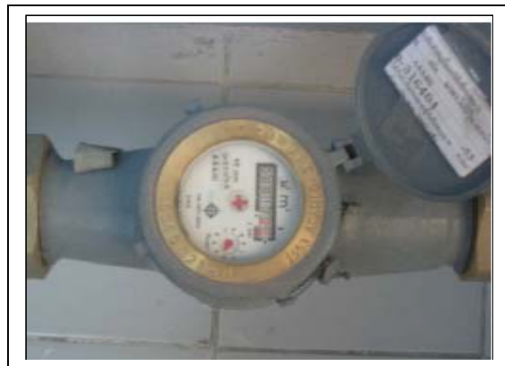
มาตรวัดน้ำจากหอทำความเย็นที่เข้าเครื่องอัดรีด
