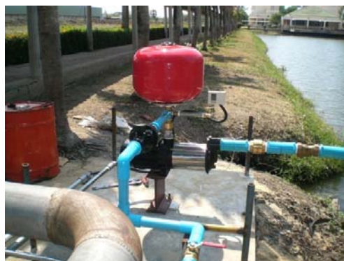
รูปการติดตั้งปั๊มเพื่อปัมน้ำจากสระน้ำ
