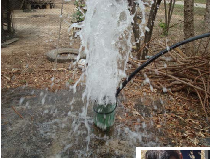
เป่าล้างบ่อน้ำบาดาลก่อนทำการอุดกลบ
