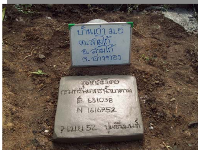
อุดกลบ่อน้ำบาดาลด้วยปูนซีเมนต์ เสร็จเรียบร้อย
