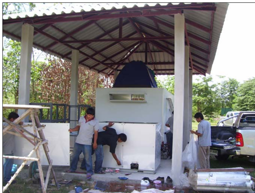
รูปที่ 5.23 ก่อนการติดตั้งระบบ 2 Stage Geothermal heat pump ร่วมกับระบบอื่นๆ
