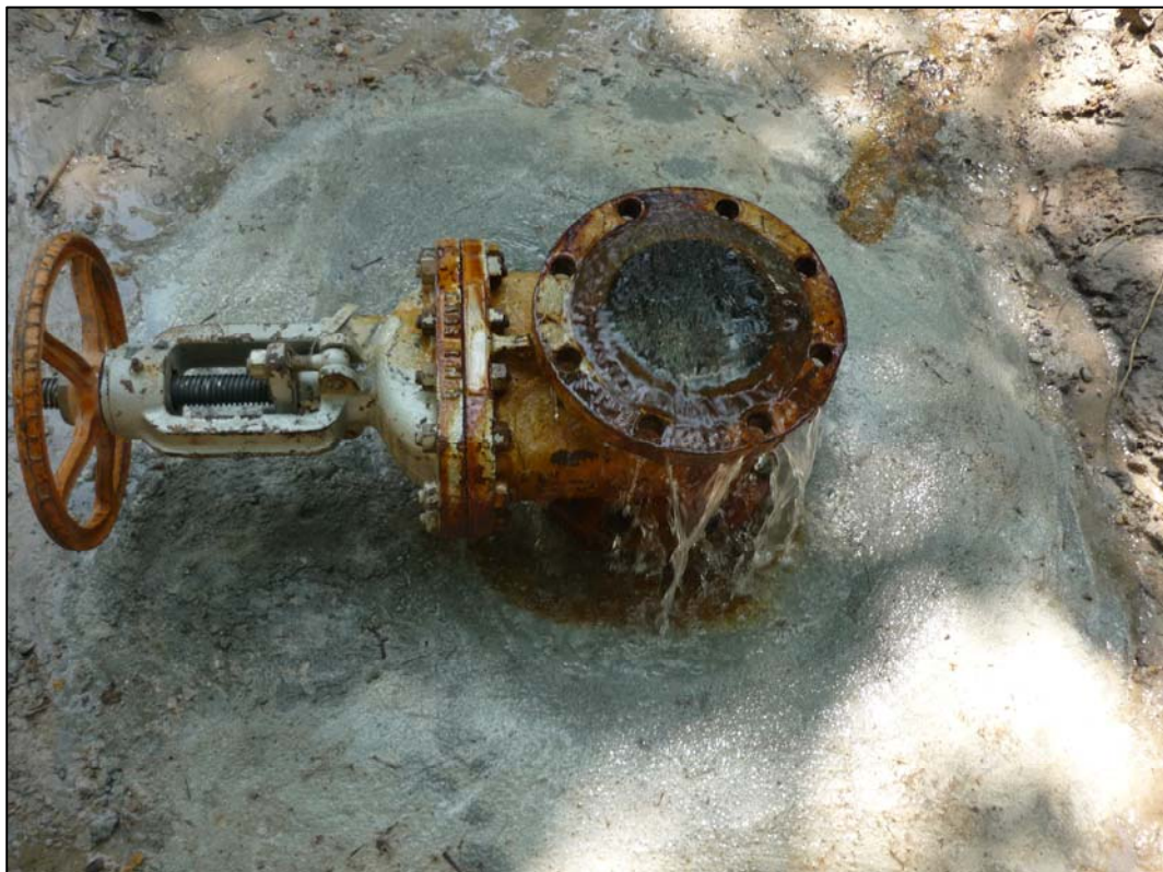
รูปที่ 5.26 ภาพแสดงหลุมผลิตน้ำร้อน แหล่งน้ำร้อน ห้วยทรายขาว อำเภอพาน จังหวัดเชียงราย
