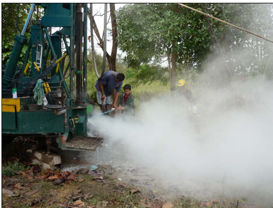
รูปที่ 4.32 การเจาะหลุมสำรวจ
