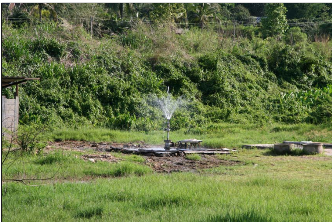
รูปที่ 5.1 ภาพแสดงหลุมผลิตน้ำร้อน แหล่งน้ำร้อนโป่งบัวบาน อำเภอพร้าว จังหวัดเชียงใหม่
