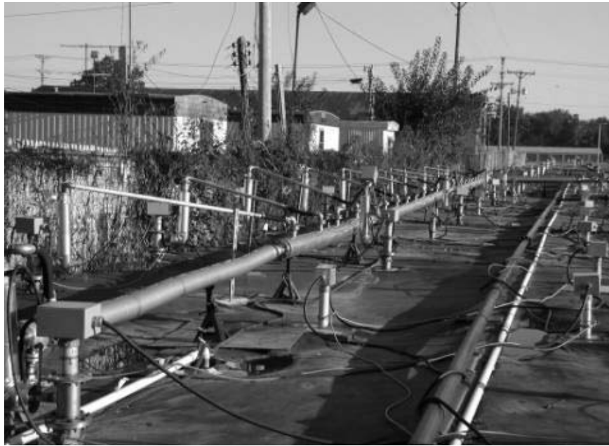
รูปที่ 6-26 แนวบ่อน้ำที่ใช้ในการบำบัดน้ำใต้ดินจากสารปนเปื้อนโดยใช้ความร้อน (thermal conductive heating) บริเวณ Midwest Site
