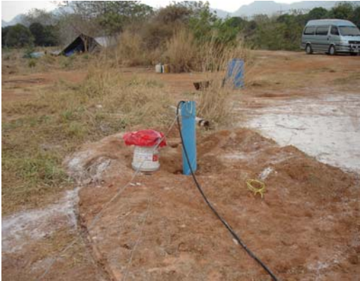
รูปที่ ๕-2 บ่อสังเกตการณ์ PZ02
