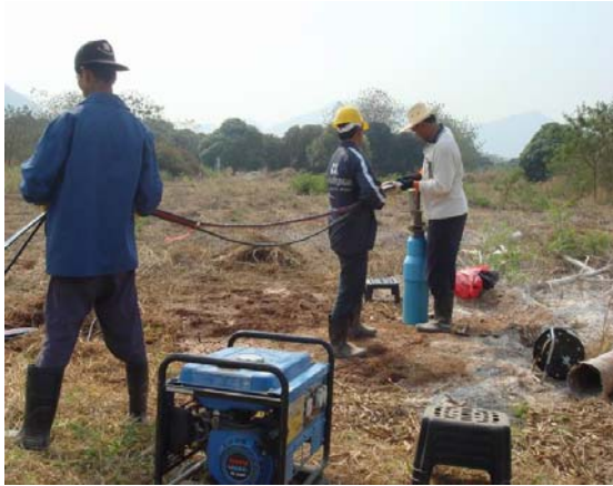
(ก) การติดตั้งเครื่องสูบน้ำเพื่อทำ slug test
