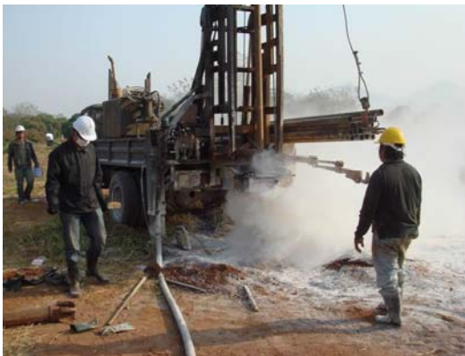
(ค) ช่วงการเจาะที่เป็นหินแข็งไม่มีน้ำ
